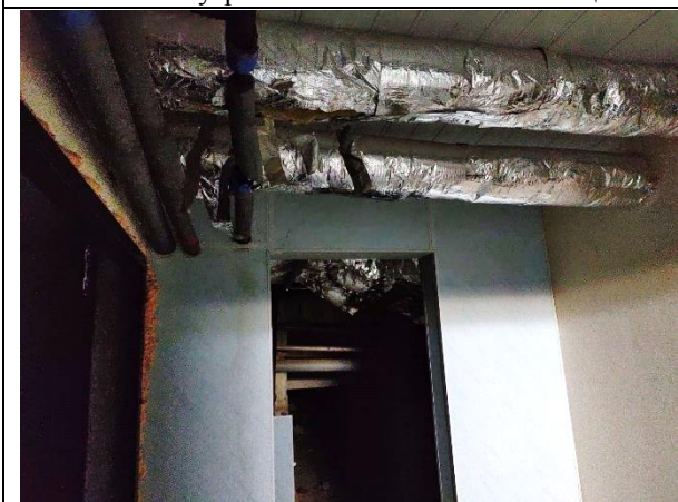
Фото 13. Внутреннее состояние Объекта оценки
