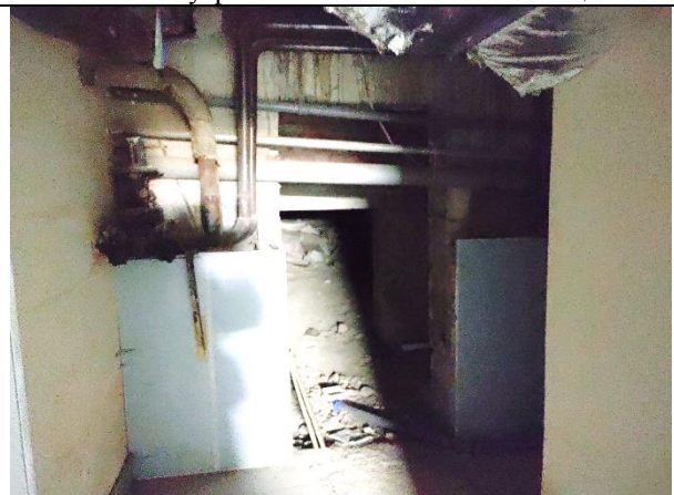
Фото 12. Внутреннее состояние Объекта оценки
