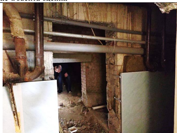
Фото 8. Внутреннее состояние Объекта оценки
