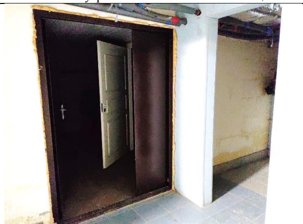
Фото 14. Внутреннее состояние Объекта оценки
