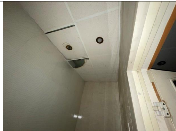
Фото 33. Типичное состояние Объекта оценки
