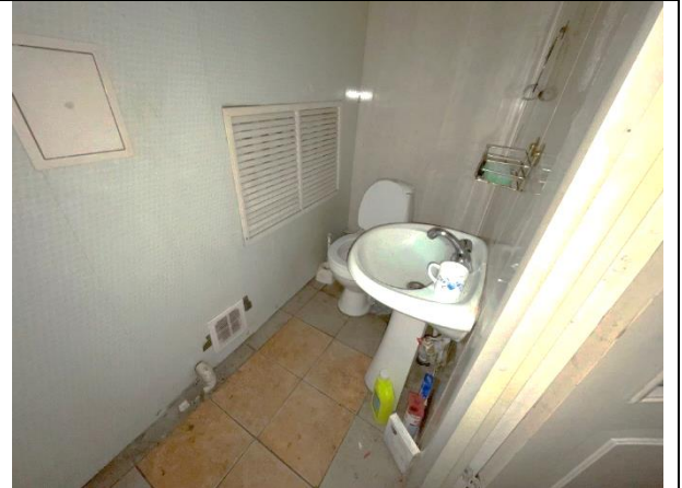
Фото 32. Типичное состояние Объекта оценки
