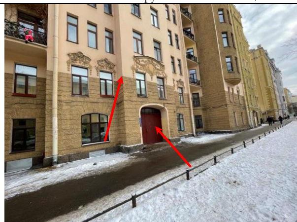
Фото 10. Вид здания расположения Объекта оценки
