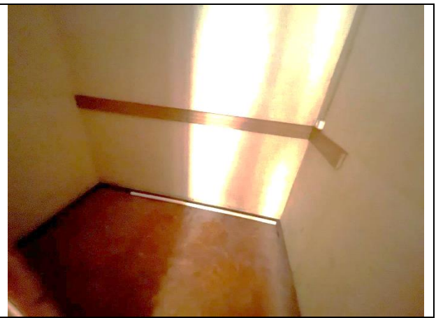
Фото 30. Типичное состояние Объекта оценки
