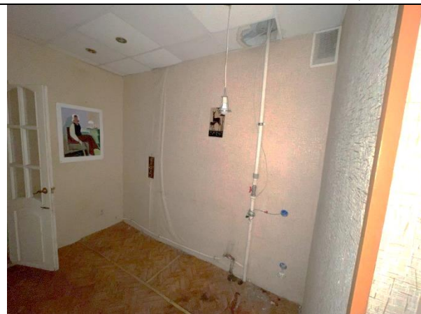
Фото 25. Типичное состояние Объекта оценки
