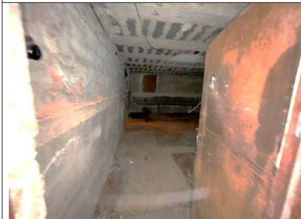
Фото 15. Типичное состояние Объекта оценки, помещение 7-Н
