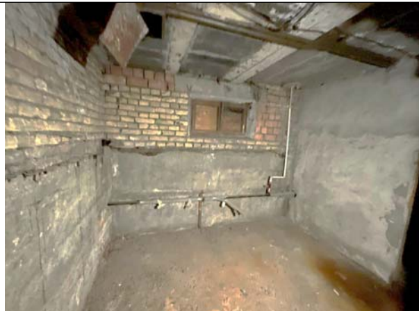
Фото 23. Типичное состояние Объекта оценки, помещение 7-Н
