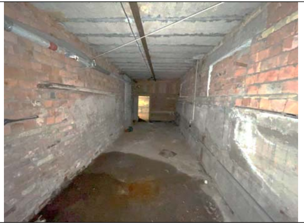
Фото 22. Типичное состояние Объекта оценки, помещение 7-Н
