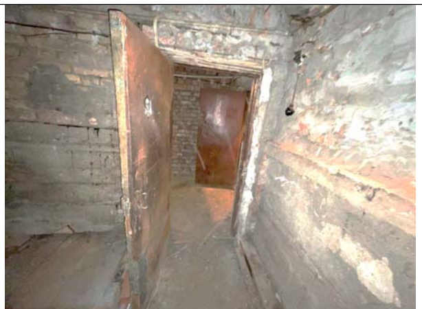
Фото 14. Типичное состояние Объекта оценки, помещение 7-Н
