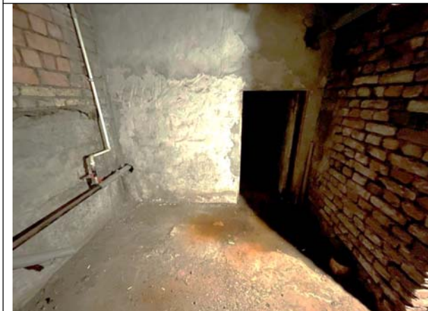
Фото 19. Типичное состояние Объекта оценки, помещение 7-Н
