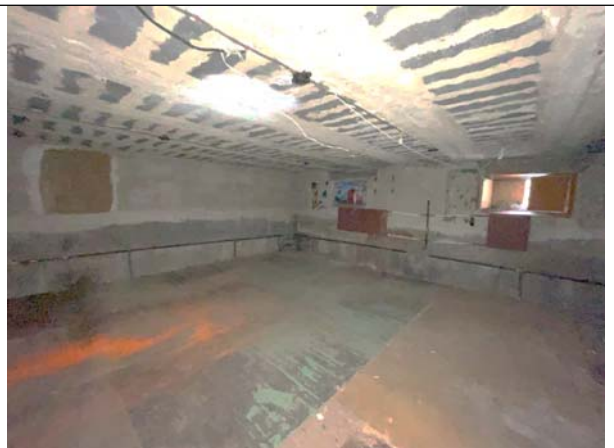
Фото 16. Типичное состояние Объекта оценки, помещение 7-Н
