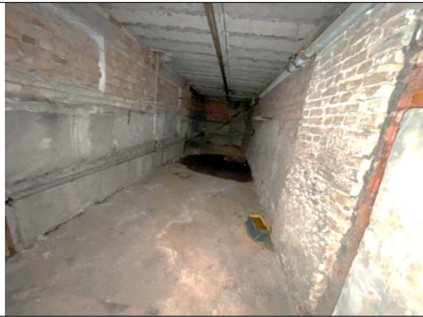
Фото 21. Типичное состояние Объекта оценки, помещение 7-Н
