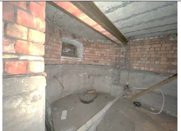
Фото 24. Типичное состояние Объекта оценки, помещение 7-Н
