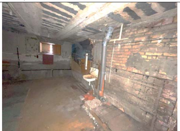
Фото 18. Типичное состояние Объекта оценки, помещение 7-Н
