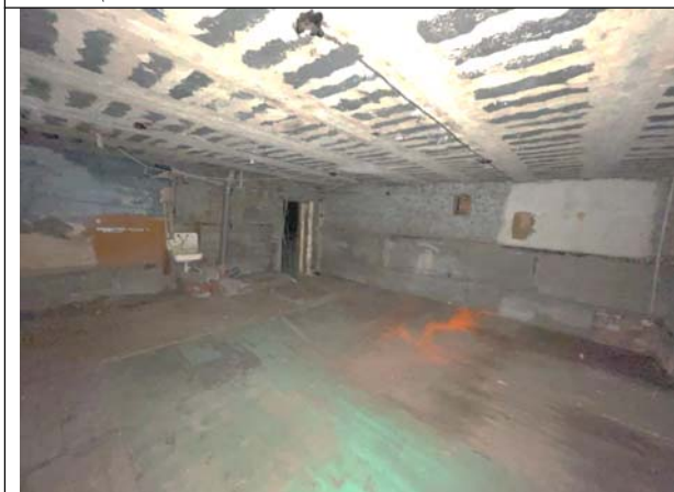
Фото 17. Типичное состояние Объекта оценки, помещение 7-Н
