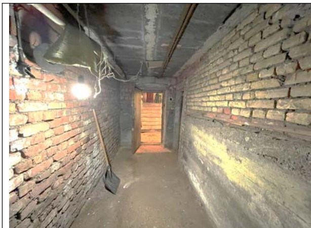
Фото 13. Типичное состояние Объекта оценки, помещение 7-Н
