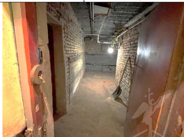
Фото 12. Типичное состояние Объекта оценки, помещение 7-Н
