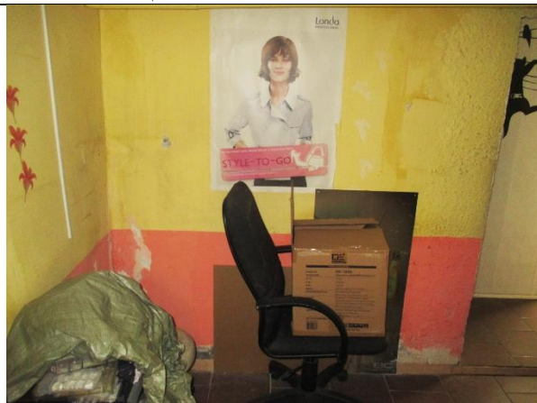
Фото 8. Внутреннее состояние Объекта оценки
