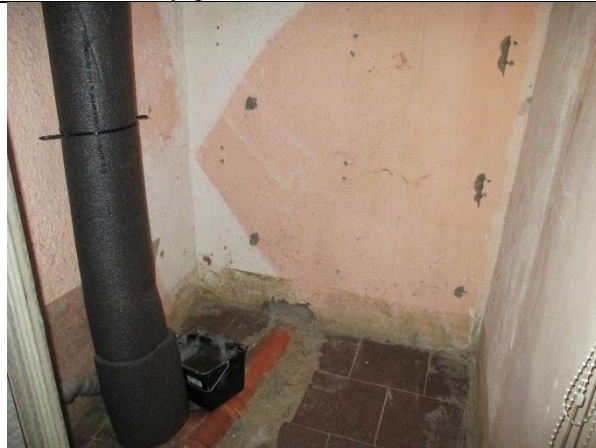
Фото 12. Внутреннее состояние Объекта оценки
