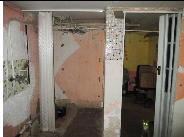
Фото 11. Внутреннее состояние Объекта оценки
