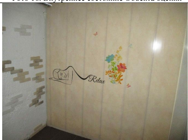
Фото 18. Внутреннее состояние Объекта оценки
