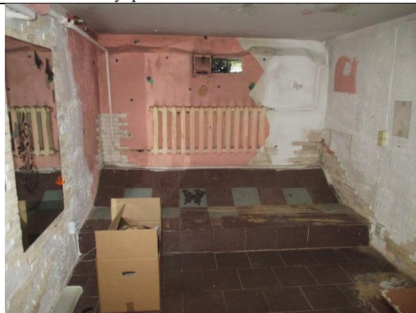
Фото 10. Внутреннее состояние Объекта оценки
