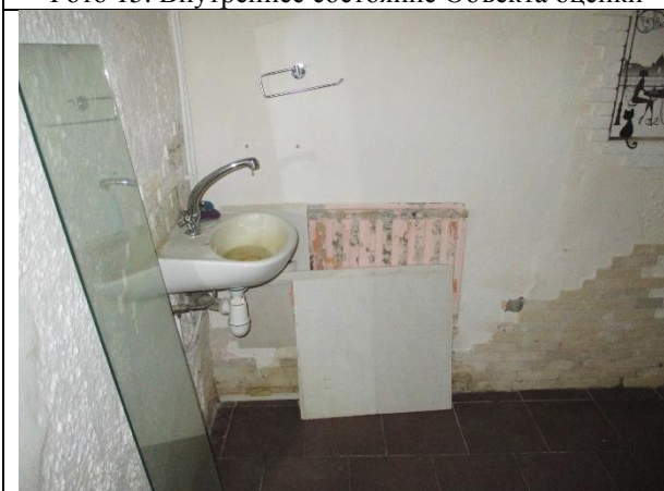
Фото 17. Внутреннее состояние Объекта оценки
