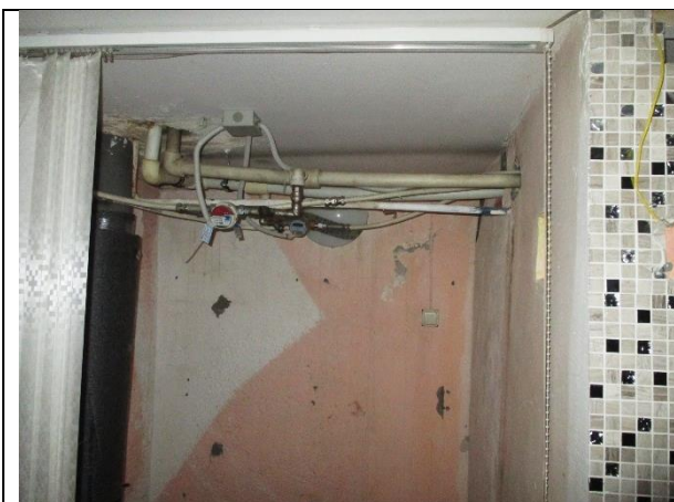
Фото 13. Внутреннее состояние Объекта оценки
