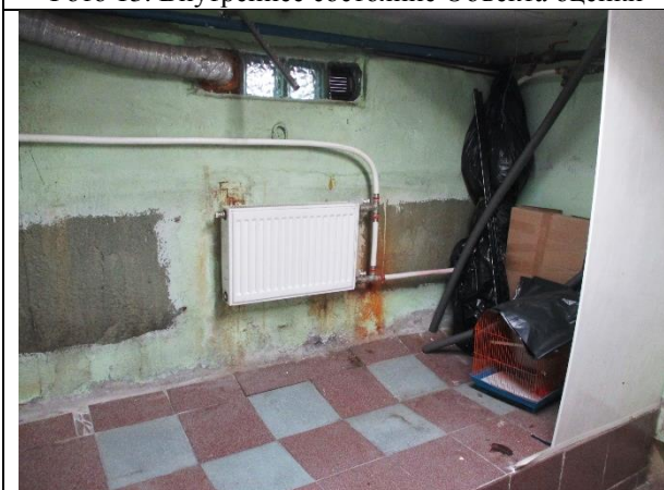
Фото 15. Внутреннее состояние Объекта оценки
