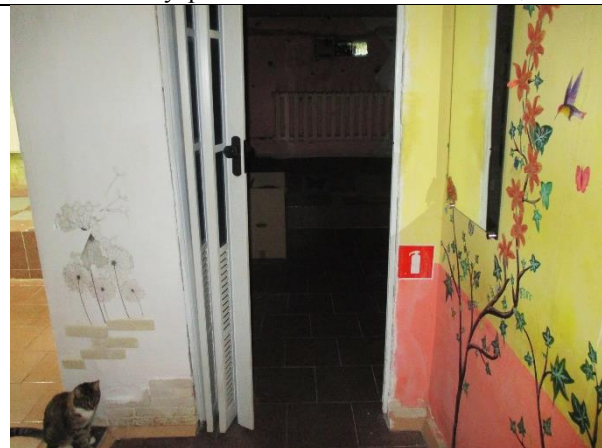
Фото 9. Внутреннее состояние Объекта оценки
