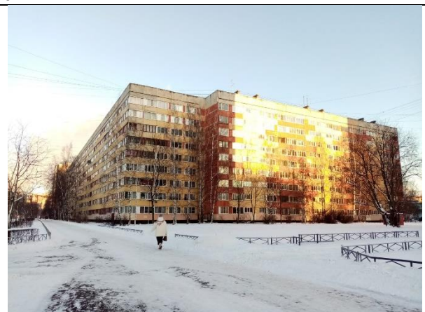
Фото 2. Вид здания, в котором расположен Объект оценки
