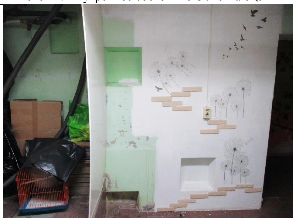
Фото 16. Внутреннее состояние Объекта оценки
