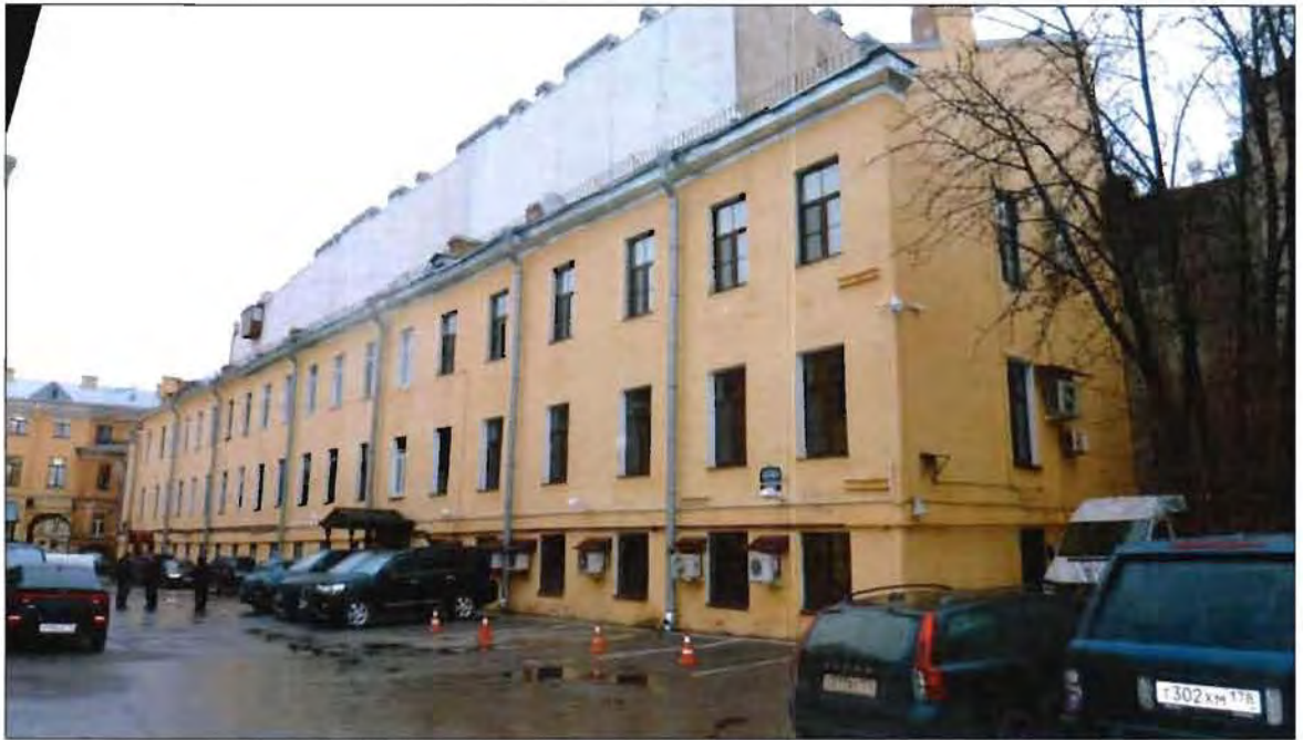
15. Корпус 8, литера Е. Общий вид с юга.
