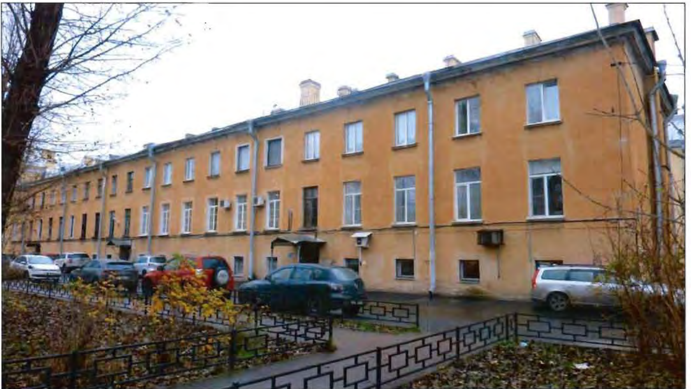
9. Корпус 2, литера Б. Вид с юга.
