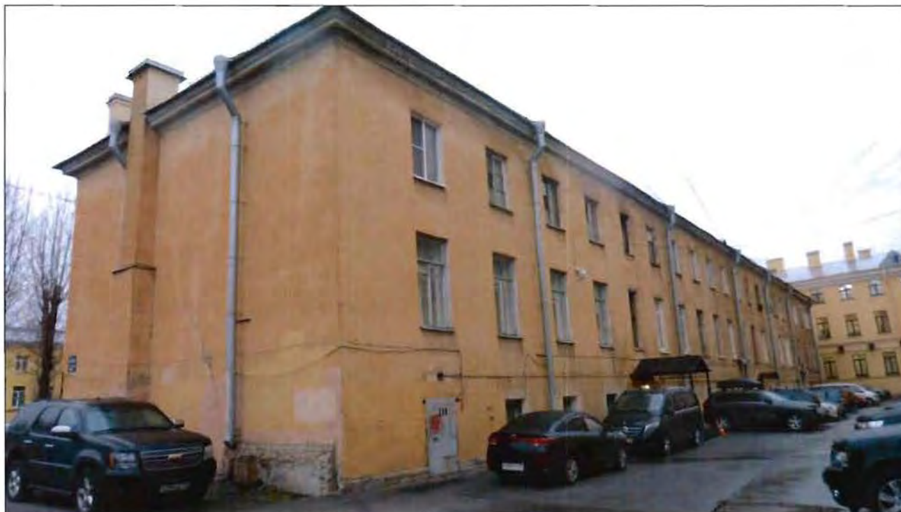
10. Корпус 2, литера Б. Вид с востока.
