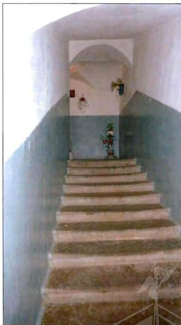
7. Корпус 3, литера В. Лестница (1-ЛК).
