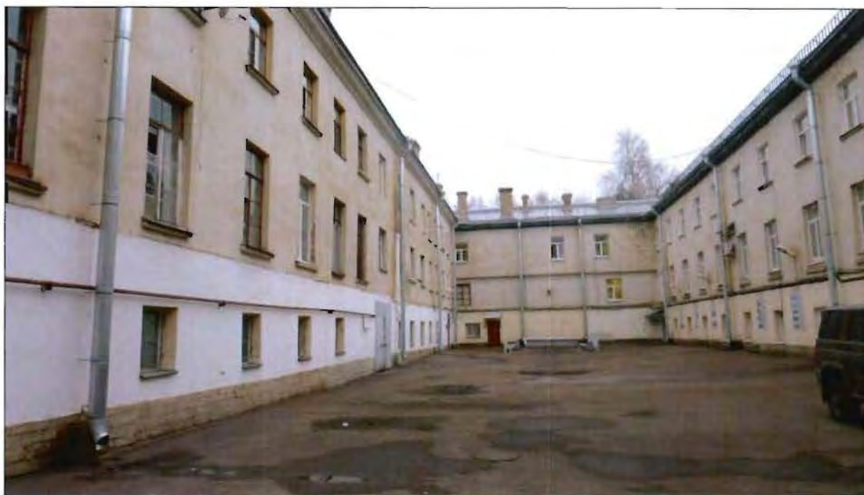
5. Корпус 3, литера В. Внутренний двор. Вид с северо-запада.
