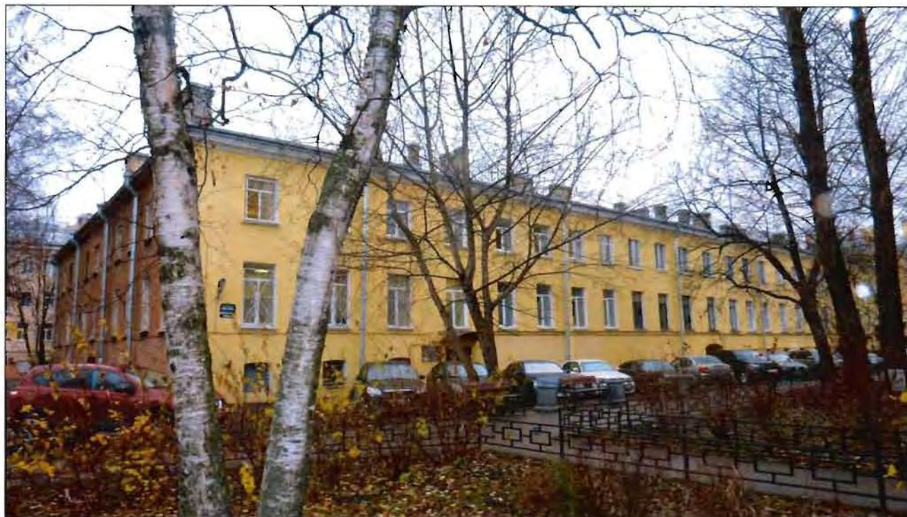
3. Корпус 3, литера В. Общий вид с востока.
