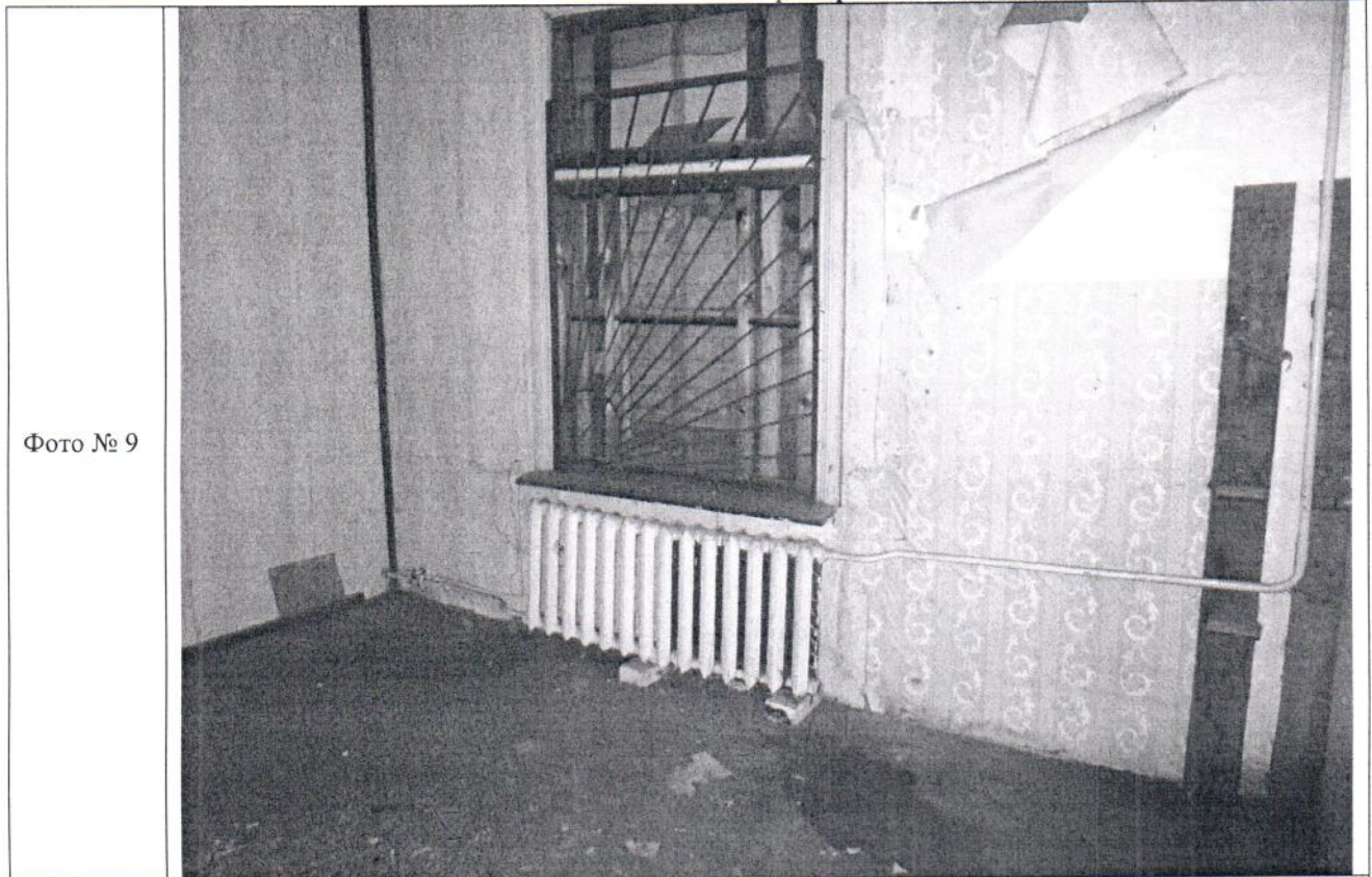
Описание: оконный проем в ч.п. 1 Объекта зашит снаружи
