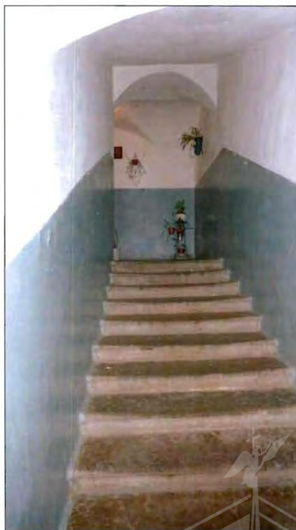
7. Корпус 3, литера В. Лестница (1-ЛК).
