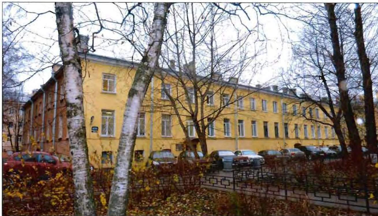
3. Корпус 3, литера В. Общий вид с востока.
