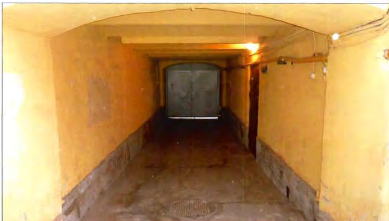
4. Корпус 3, литера В. Северный воротный проезд.
