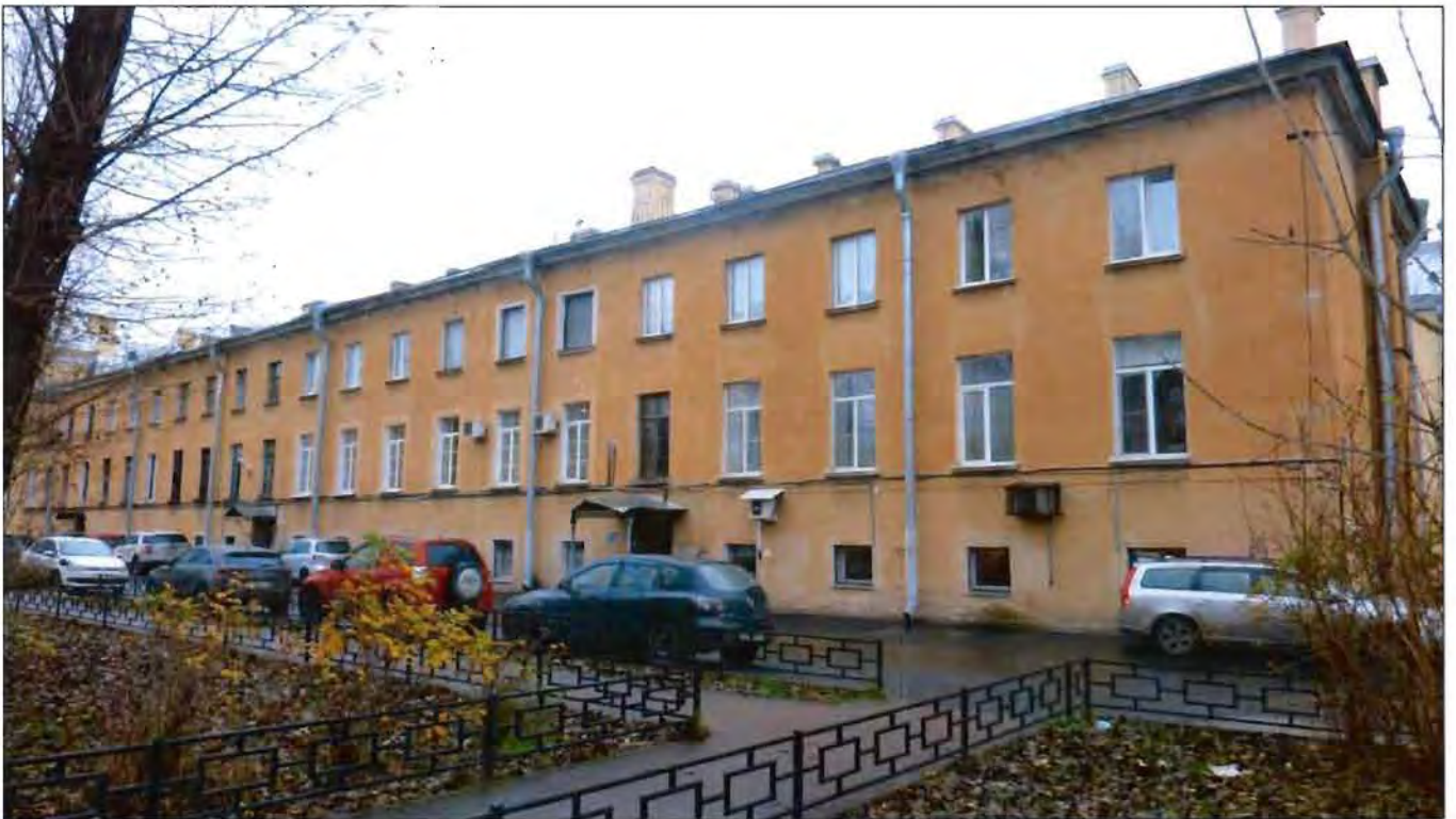
9. Корпус 2, литера Б. Вид с юга.
