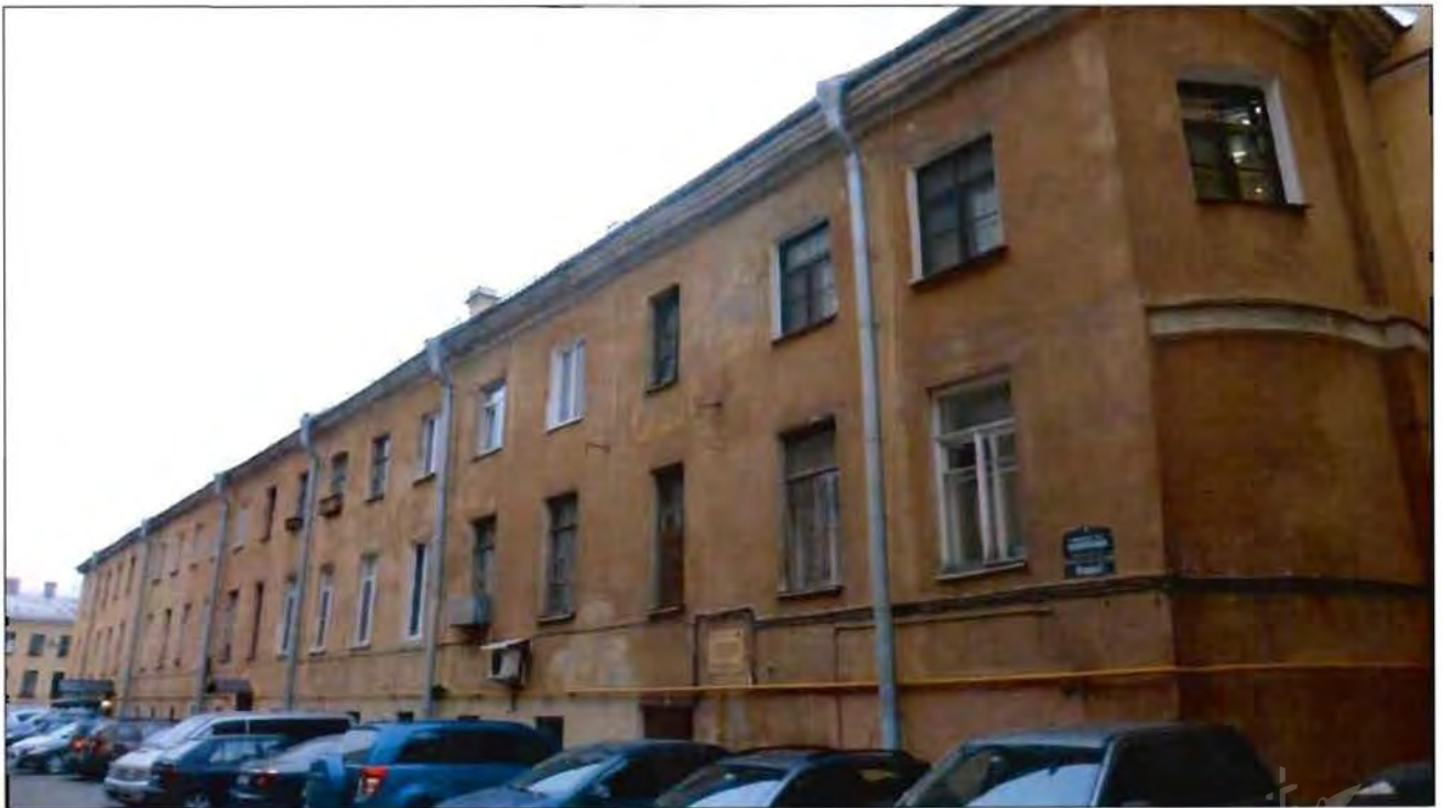
11. Корпус 2, литера Б. Вид с севера.
