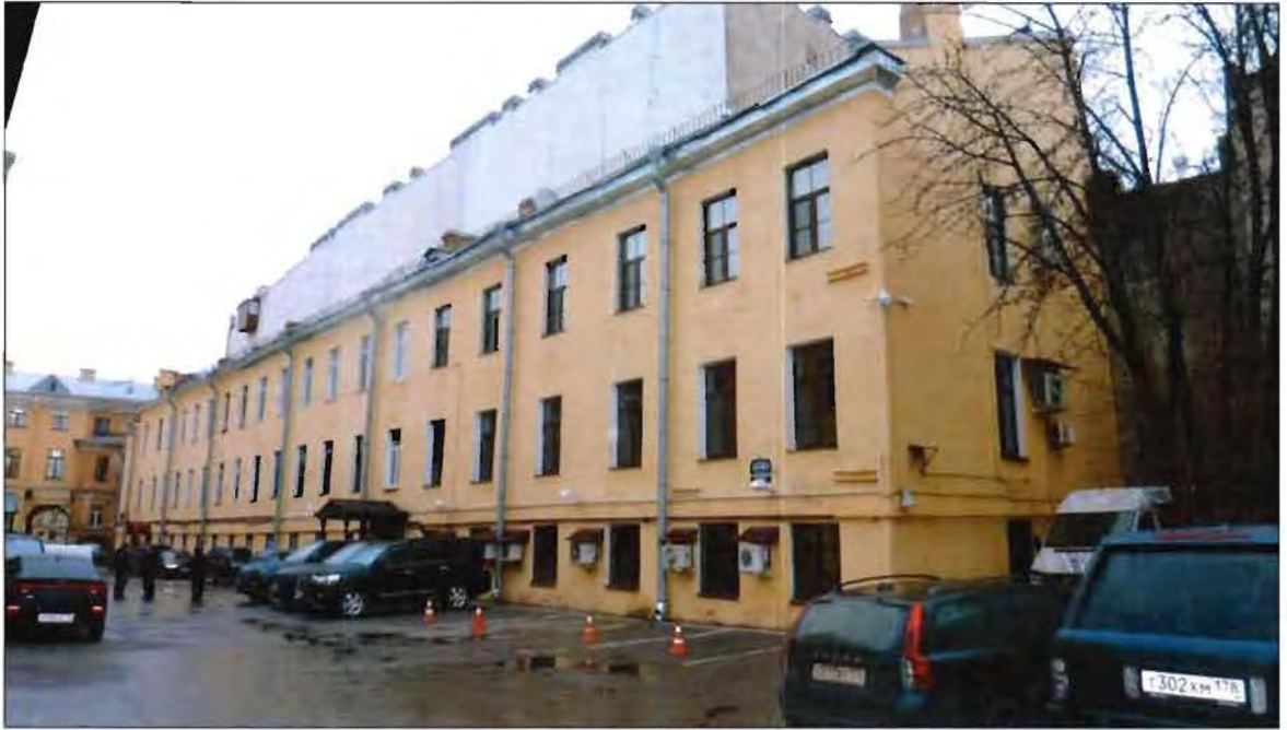
15. Корпус 8, литера Е. Общий вид с юга.
