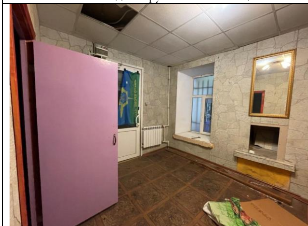
Фото 15. Типичное состояние Объекта оценки
