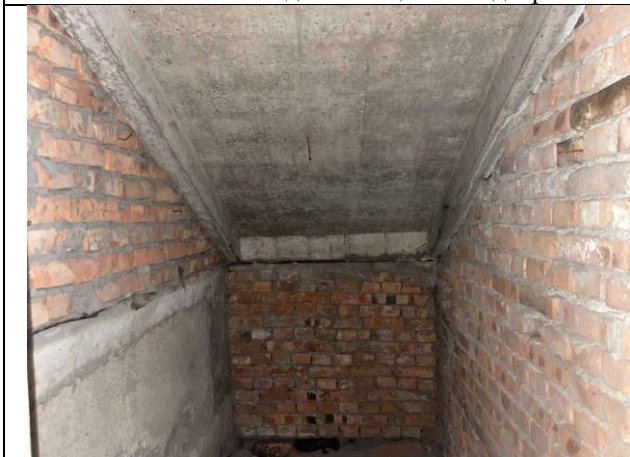
Фото № 7 – Внутреннее состояние помещения
