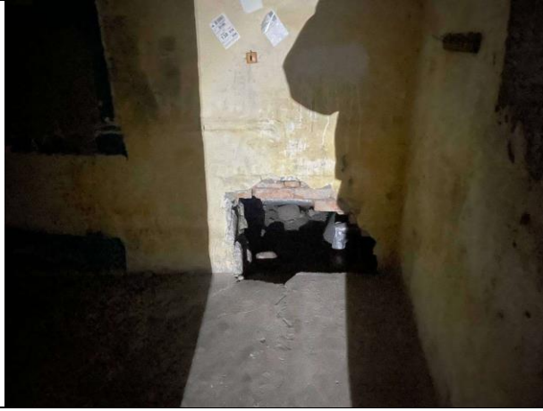
Фото № 13 – Внутреннее состояние помещения
