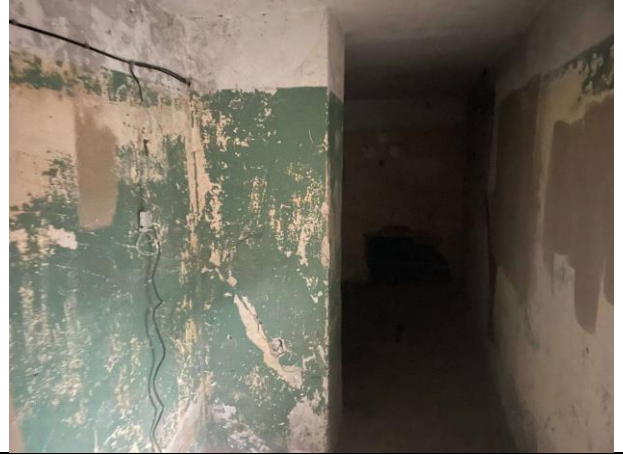
Фото № 16 – Внутреннее состояние помещения
