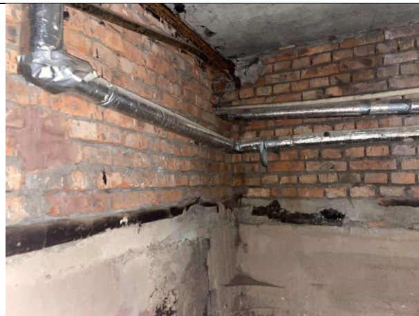
Фото № 6 – Внутреннее состояние помещения
