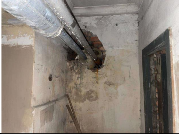
Фото № 15 – Внутреннее состояние помещения
