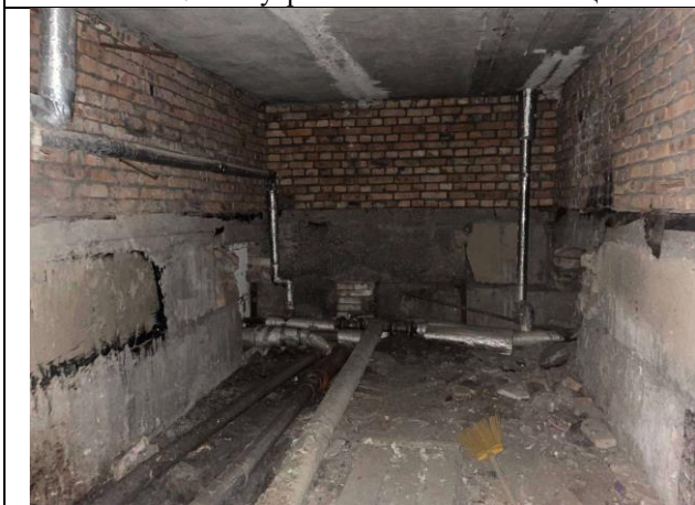
Фото № 9 – Внутреннее состояние помещения
