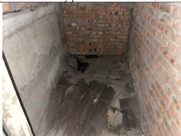
Фото № 10 – Внутреннее состояние помещения
