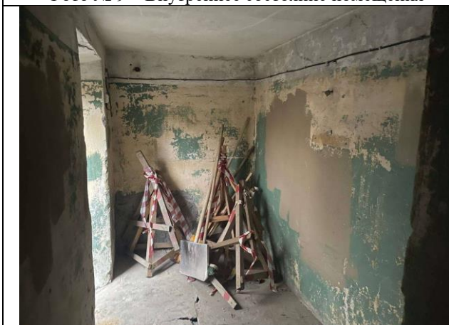
Фото № 11 – Внутреннее состояние помещения
