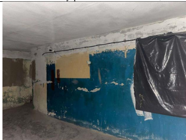
Фото № 8 – Внутреннее состояние помещения
