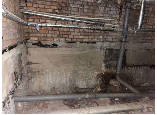
Фото № 14 – Внутреннее состояние помещения
