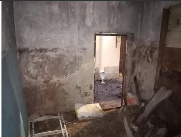
Фото № 11. Внутреннее состояние здания
