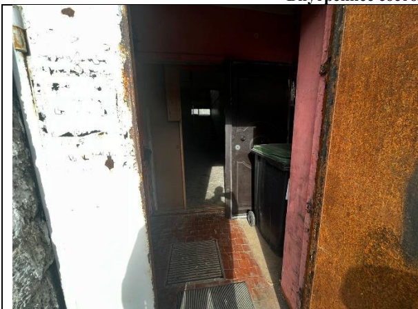
Фото 7. Внутреннее состояние Объекта оценки
