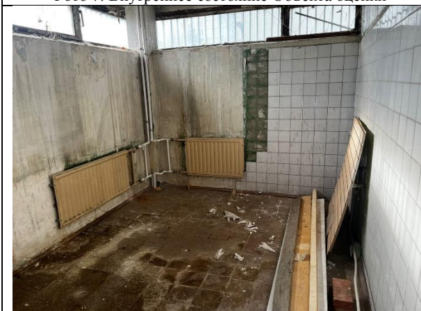
Фото 9. Внутреннее состояние Объекта оценки
