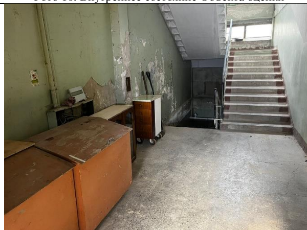
Фото 12. Внутреннее состояние Объекта оценки
