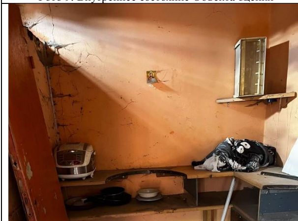
Фото 11. Внутреннее состояние Объекта оценки
