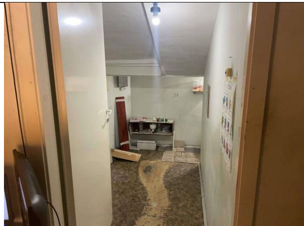
Фото № 8 – Внутреннее состояние помещения
