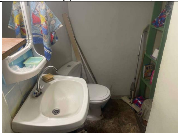
Фото № 10 – Внутреннее состояние помещения
