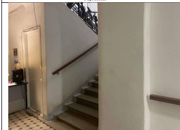
Фото № 5 – Вход в помещение
