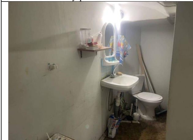
Фото № 9 – Внутреннее состояние помещения
