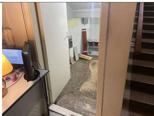
Фото № 6 – Вход в помещение
