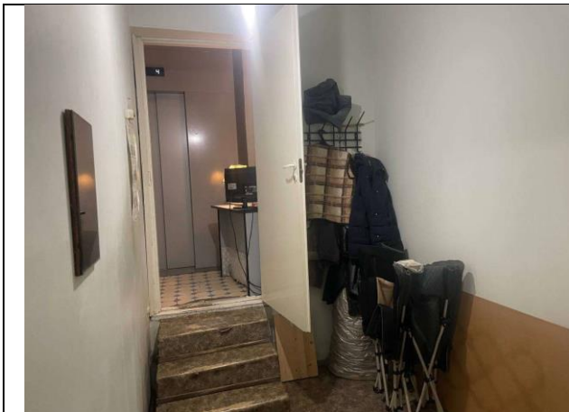
Фото № 7 – Внутреннее состояние помещения
