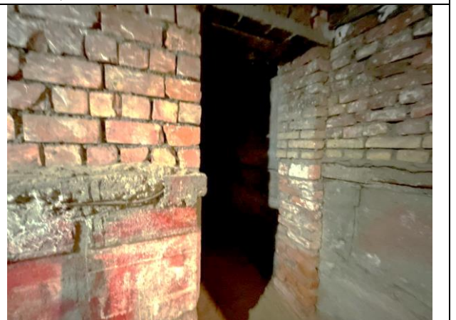
Фото 18. Типичное состояние Объекта оценки, помещение 8-Н
