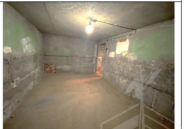
Фото 20. Типичное состояние Объекта оценки, помещение 8-Н
