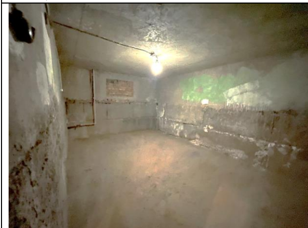
Фото 19. Типичное состояние Объекта оценки, помещение 8-Н
