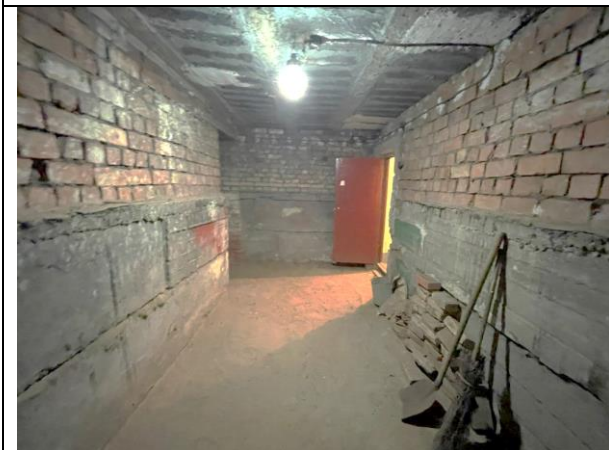
Фото 15. Типичное состояние Объекта оценки, помещение 8-Н
