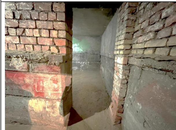
Фото 17. Типичное состояние Объекта оценки, помещение 8-Н
