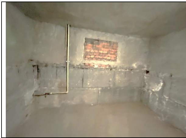
Фото 21. Типичное состояние Объекта оценки, помещение 8-Н
