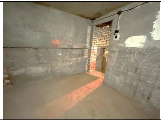
Фото 22. Типичное состояние Объекта оценки, помещение 8-Н
