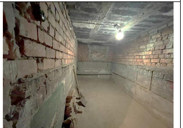
Фото 16. Типичное состояние Объекта оценки, помещение 8-Н
