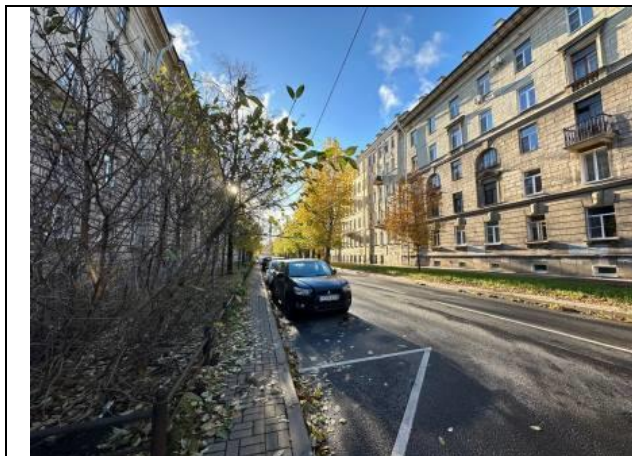
Фото № 1 – Подъездные пути
