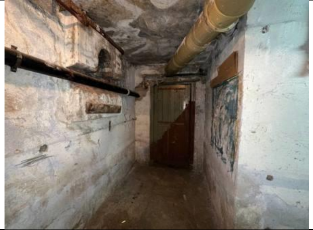
Фото № 16 – Внутреннее состояние помещения
