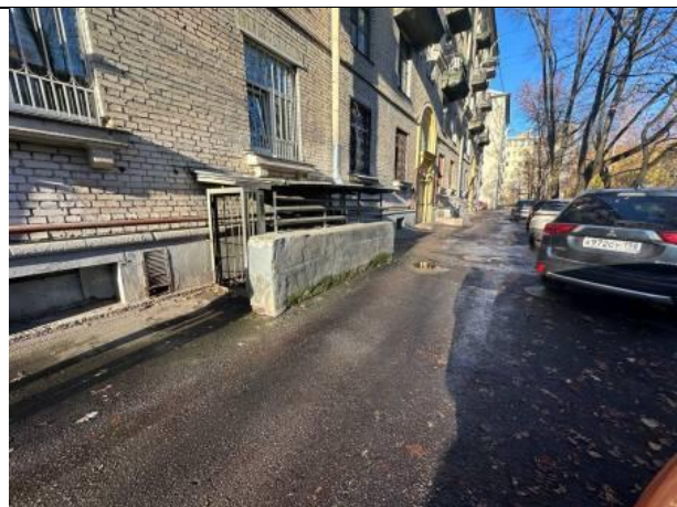
Фото № 8 – Вход в помещение со двора через приямок
