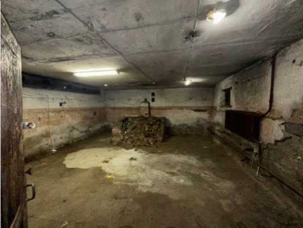
Фото № 17 – Внутреннее состояние помещения
