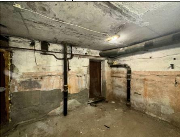
Фото № 19 – Внутреннее состояние помещения
