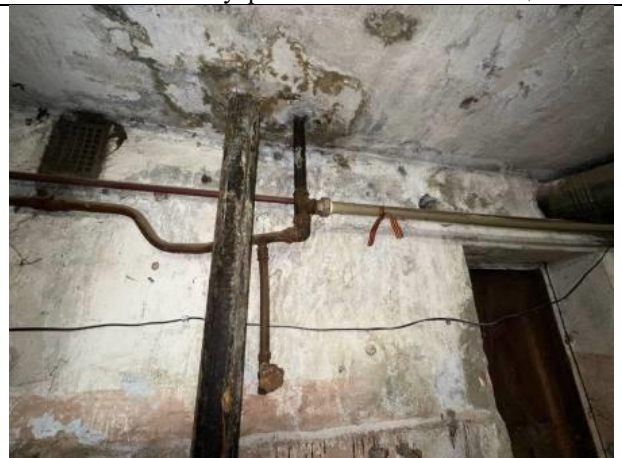
Фото № 20 – Внутреннее состояние помещения
