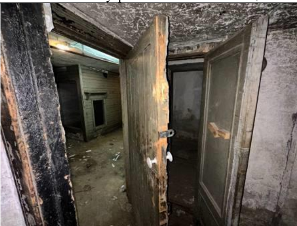
Фото № 21 – Внутреннее состояние помещения
