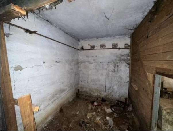
Фото № 15 – Внутреннее состояние помещения
