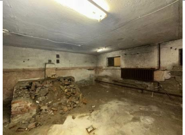
Фото № 18 – Внутреннее состояние помещения
