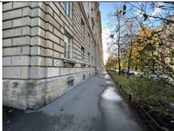
Фото № 2 – Подъездные пути
