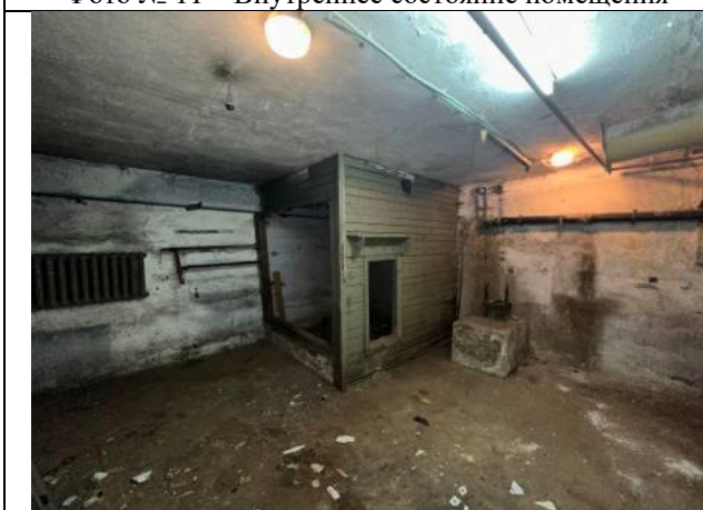
Фото № 13 – Внутреннее состояние помещения
