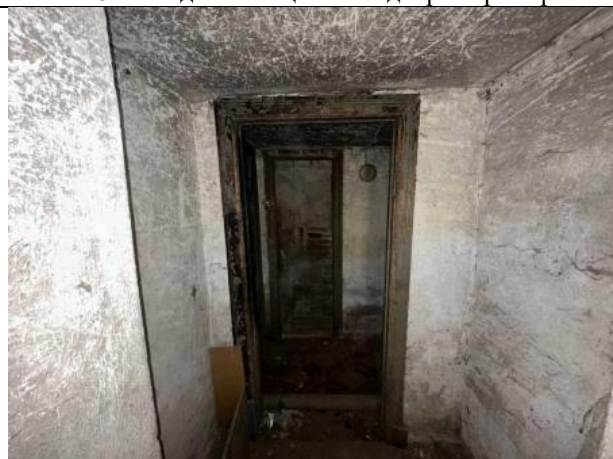
Фото № 10 – Внутреннее состояние помещения
