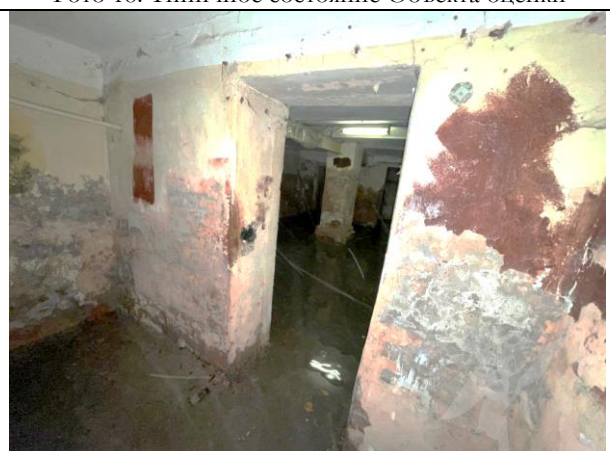
Фото 20. Типичное состояние Объекта оценки (подвал подтапливаемый, прорыв трубы был, пол затоплен)
