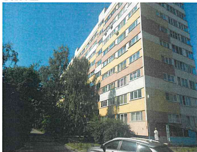
Фото №4 (вход в помещение)
