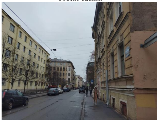
Фото 3. Дворовая территория. Ближайшее окружение
