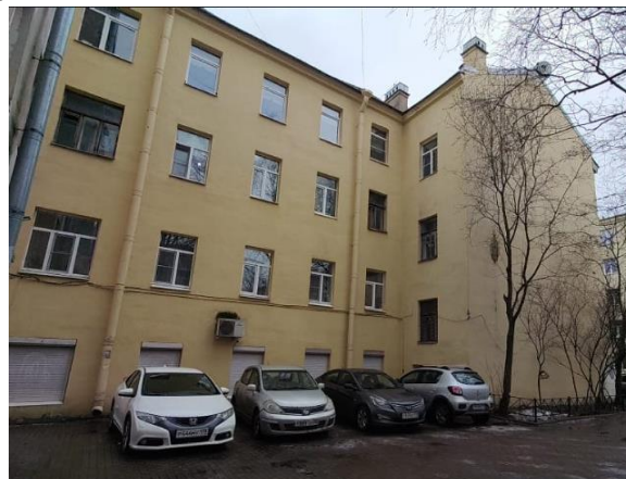
Фото 2. Вид здания, в котором расположен Объект оценки
