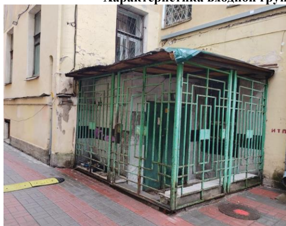
Фото 5. Общий вход со двора
