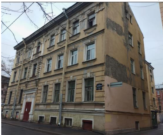
Фото 1. Вид здания, в котором расположен Объект оценки
