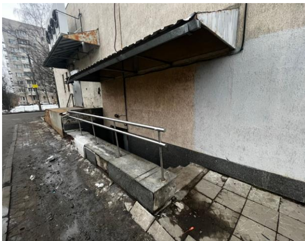
Фото 3. Общий вход с улицы
