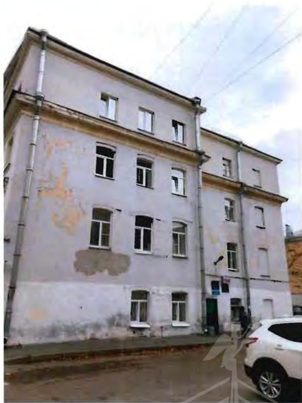
8. Западный фасад объекта культурного наследия.
