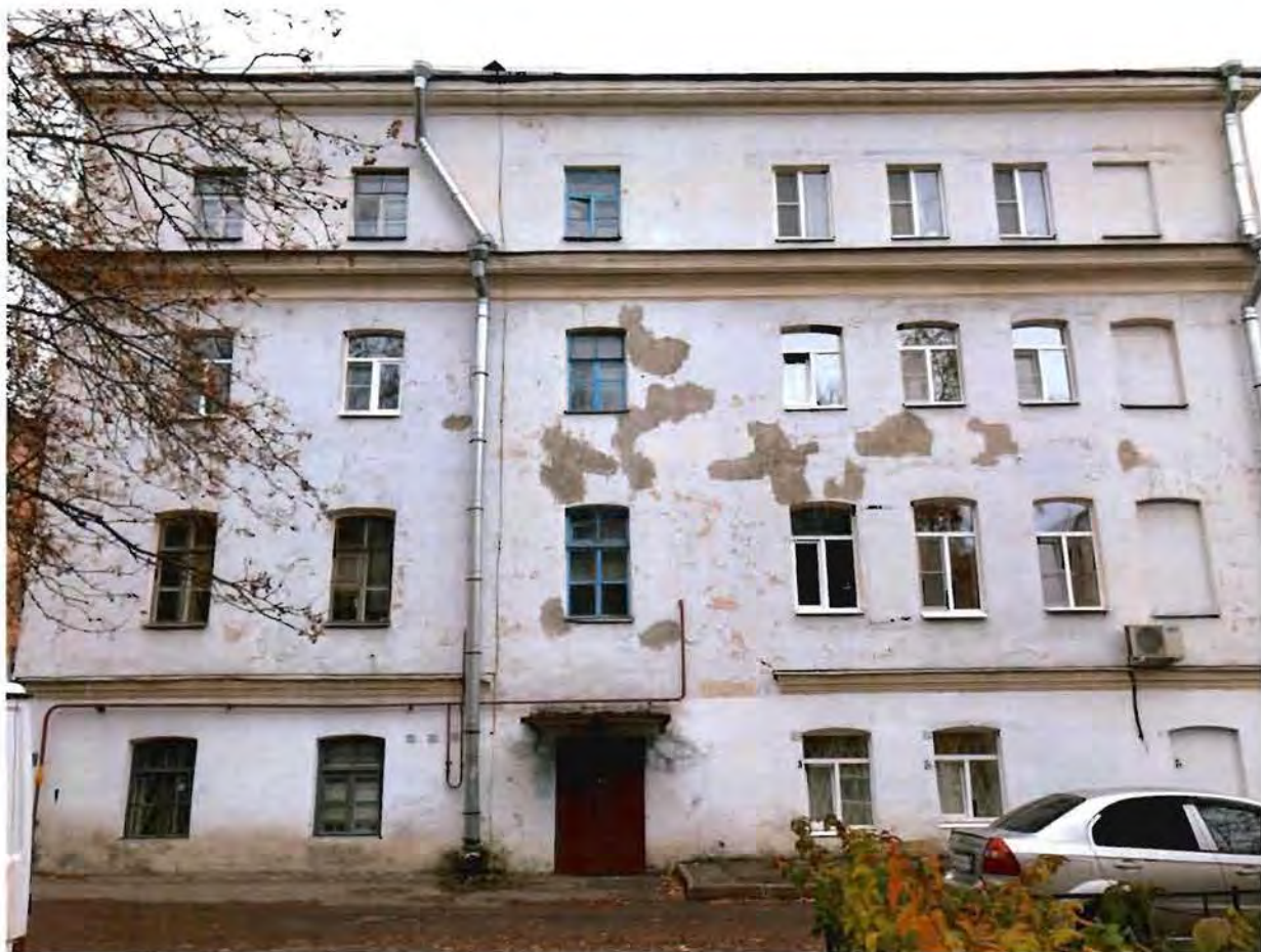
6. Восточный фасад объекта культурного наследия.
