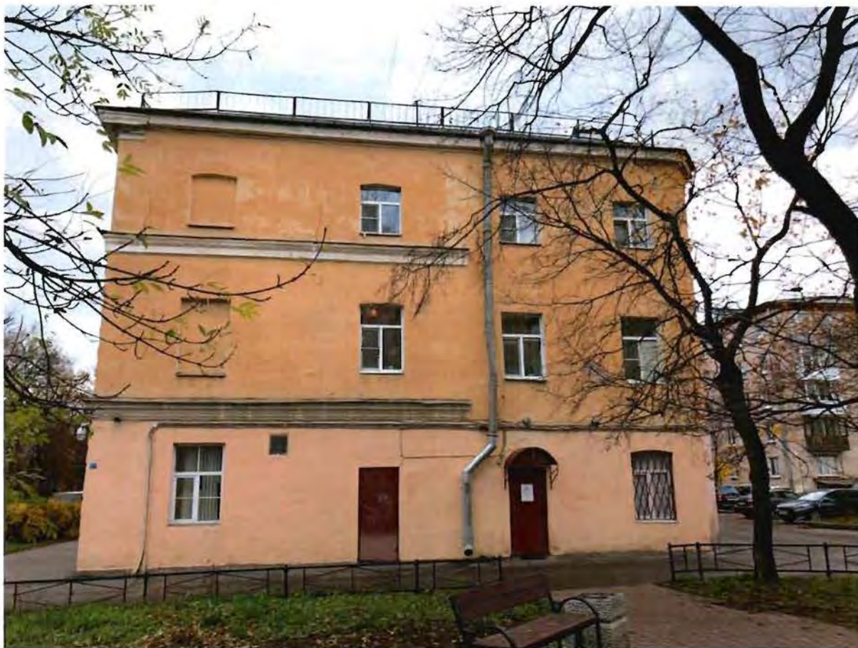
2. Восточный фасад объекта культурного наследия.
