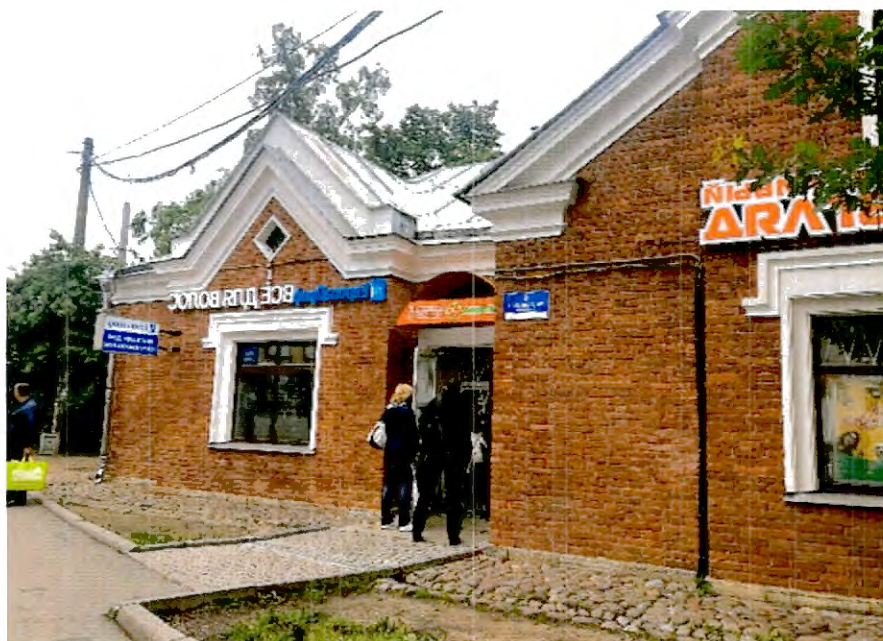
6. Лицевой фасад объекта культурного наследия «Четыре служебных корпуса». Вид с северной стороны (ул. Савушкина, д. 6, литера А)
