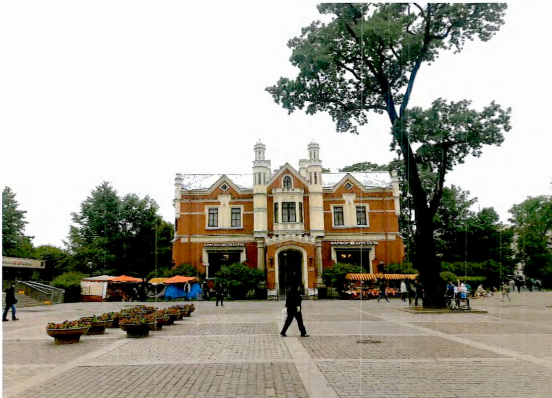
1. Лицевой фасад объекта культурного наследия «Дача» (вид с восточной стороны)
