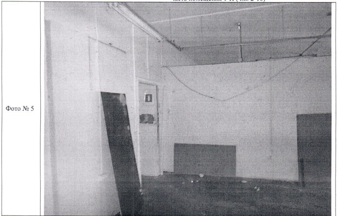
Описание: в ч.п. 2 Объекта демонтирована перегородка
