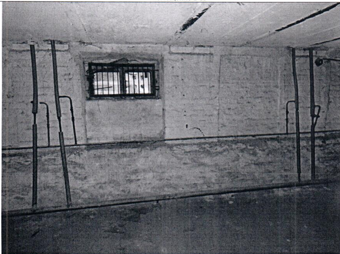
Описание: в ч.п. 13 Объекта заложен оконный проём
