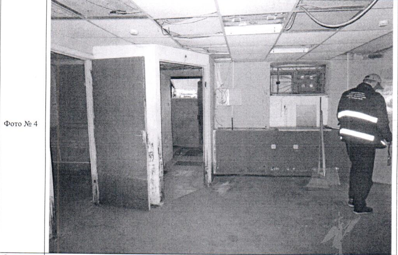
Описание: между ч.п. 1 и 2 Объекта дверной проём переоборудован в проём без дверного блока
