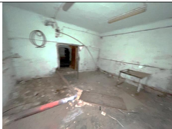
Фото 27. Типичное состояние Объекта оценки
