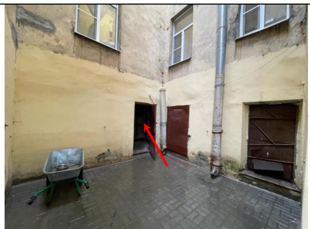
Фото 20. Вид здания расположения Объекта оценки, входная группа Объекта оценки
