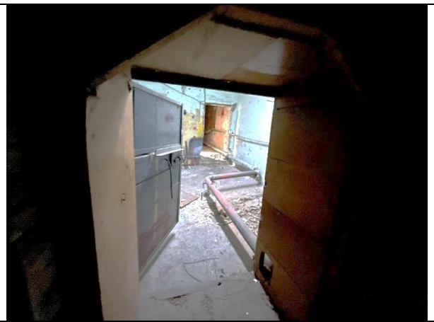
Фото 32. Типичное состояние Объекта оценки
