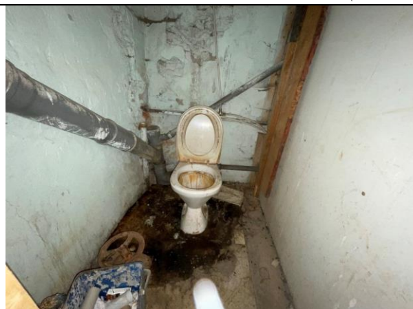
Фото 37. Типичное состояние Объекта оценки
