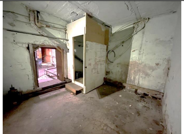
Фото 34. Типичное состояние Объекта оценки
