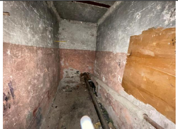
Фото 26. Типичное состояние Объекта оценки
