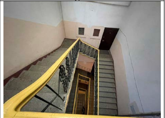
Фото 8. Лестничный проём Объекта оценки
