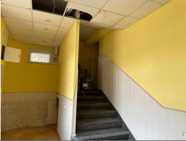
Фото № 15 – Внутреннее состояние помещения
