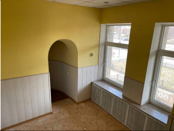
Фото № 13 – Внутреннее состояние помещения
