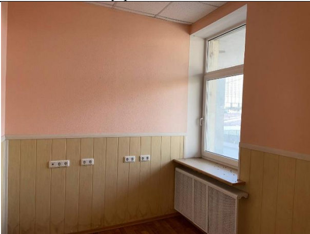
Фото № 19 – Внутреннее состояние помещения
