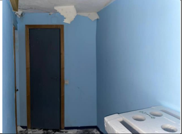
Фото № 14 – Внутреннее состояние помещения
