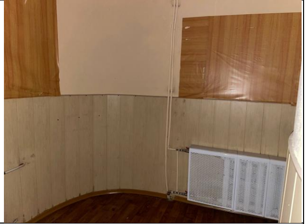
Фото № 16 – Внутреннее состояние помещения
