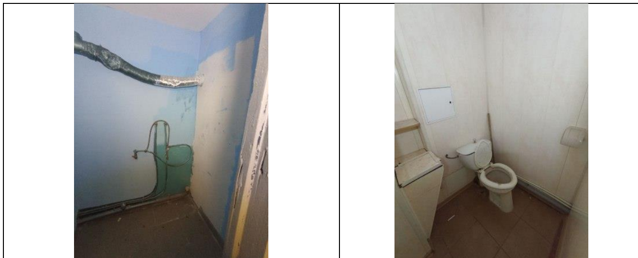
Фото № 21 – Внутреннее состояние помещения
