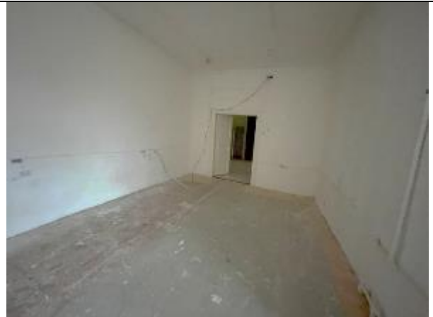
Фото 62. Типичное состояние Объекта оценки
