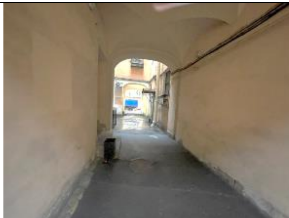
Фото 68. Проход через арку к Объекту оценки
