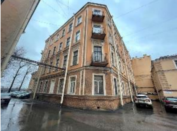
Фото 21. Вид здания расположения Объекта оценки, оконная группа Объекта оценки
