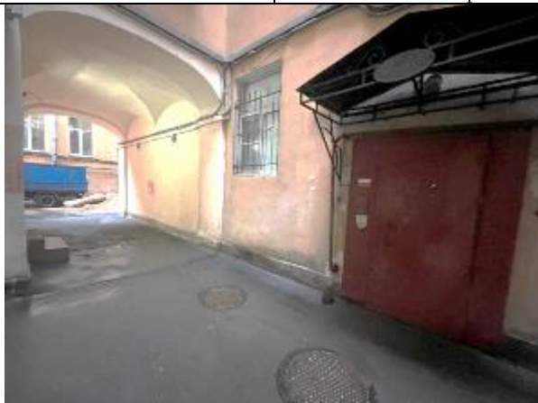
Фото 69. Проход через арку к Объекту оценки (входная группа Объекта оценки, второй вход)
