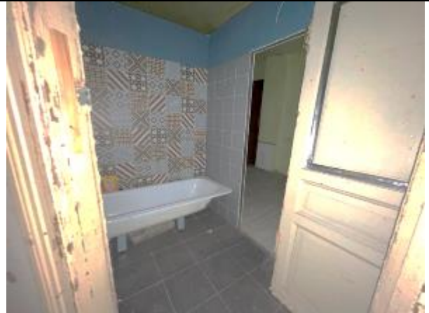
Фото 64. Типичное состояние Объекта оценки
