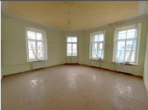
Фото 35. Типичное состояние Объекта оценки, балкон, окна во двор
