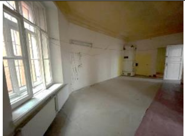
Фото 46. Типичное состояние Объекта оценки
