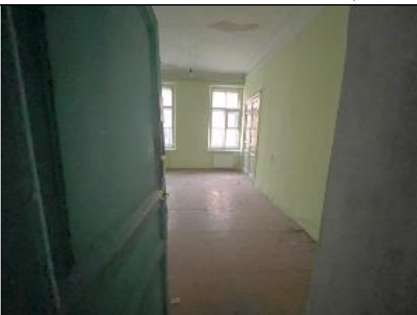
Фото 33. Типичное состояние Объекта оценки
