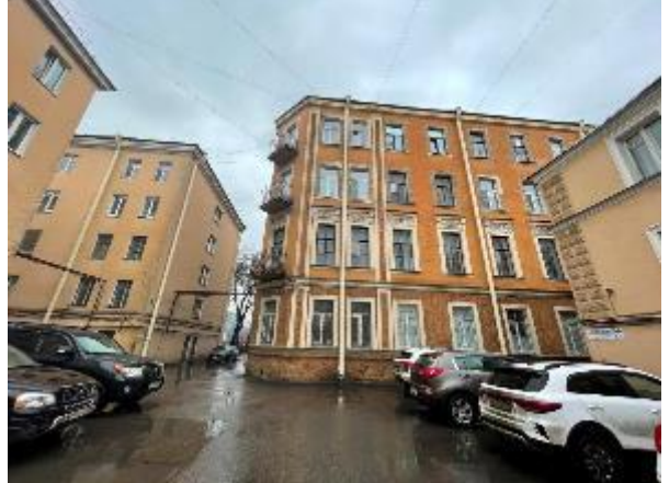
Фото 22. Вид здания расположения Объекта оценки, оконная группа Объекта оценки
