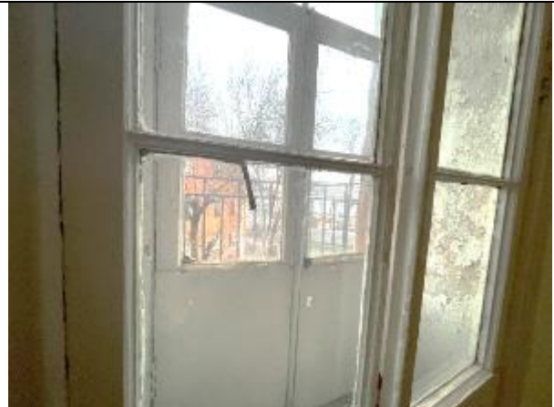
Фото 36. Типичное состояние Объекта оценки, балкон, окна во двор
