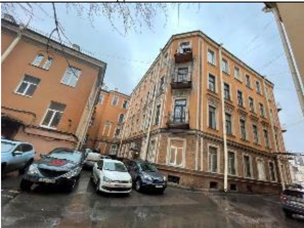
Фото 23. Вид здания расположения Объекта оценки, оконная группа Объекта оценки
