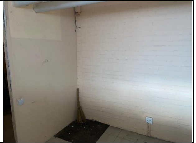
Фото № 38 – Внутреннее состояние помещения
