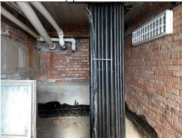
Фото № 35 – Внутреннее состояние помещения
