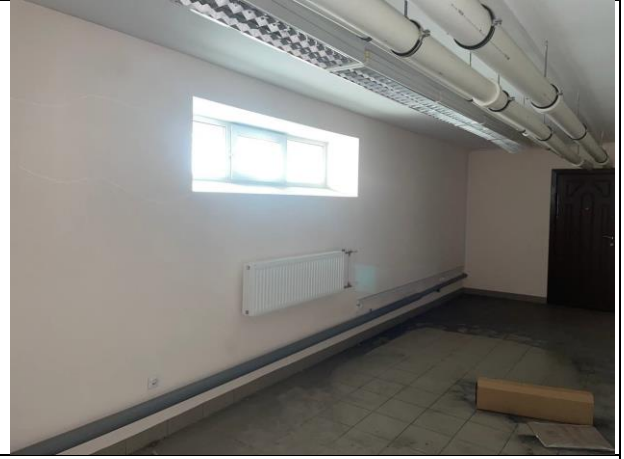
Фото № 30 – Внутреннее состояние помещения
