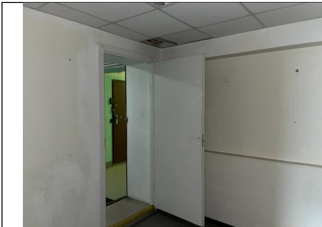
Фото № 21 – Внутреннее состояние помещения
