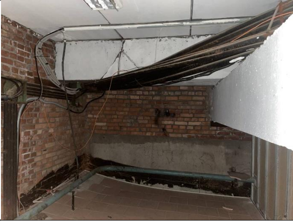
Фото № 29 – Внутреннее состояние помещения
