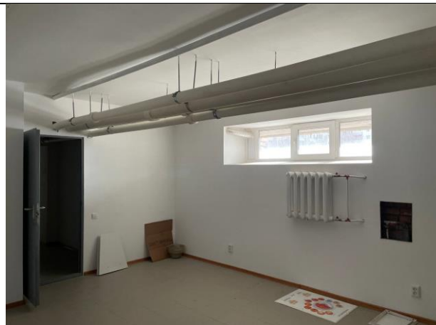
Фото № 14 – Внутреннее состояние помещения
