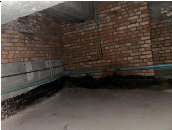
Фото № 33 – Внутреннее состояние помещения
