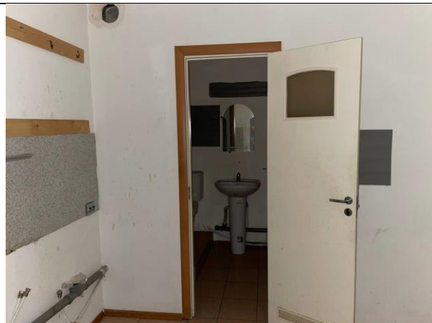
Фото № 22 – Внутреннее состояние помещения
