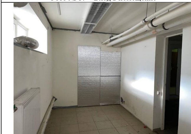
Фото № 19 – Внутреннее состояние помещения
