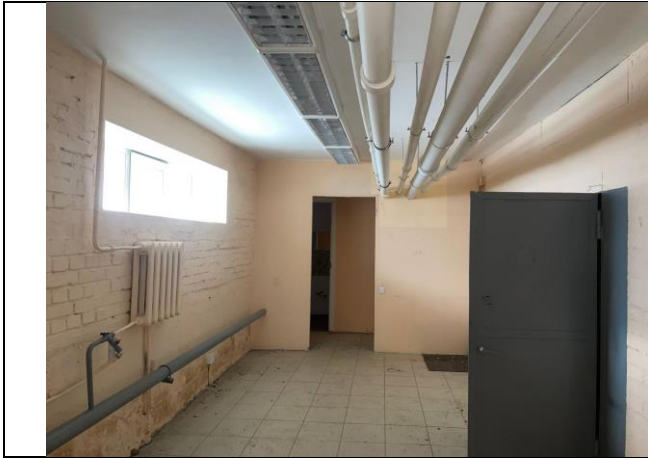
Фото № 37 – Внутреннее состояние помещения
