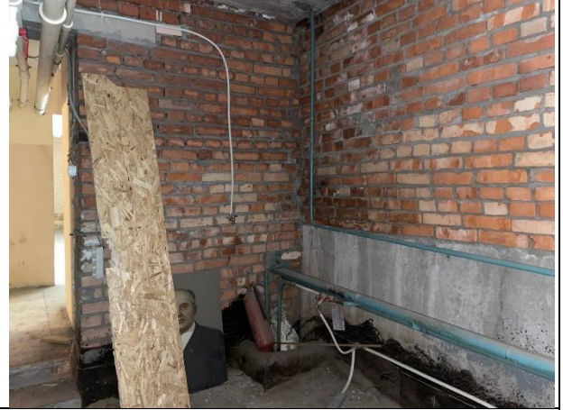
Фото № 32 – Внутреннее состояние помещения
