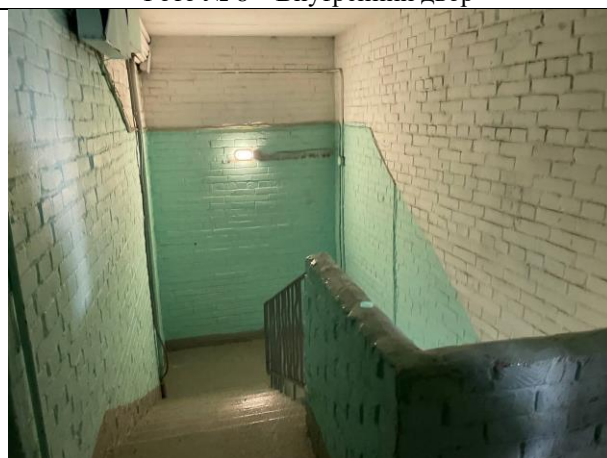
Фото № 10 – Лестничная клетка
