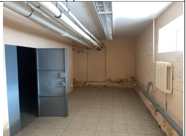
Фото № 34 – Внутреннее состояние помещения
