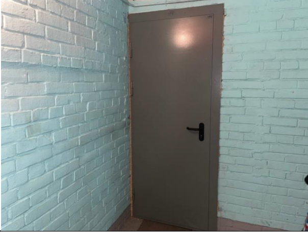
Фото № 31 – Вход в помещение
