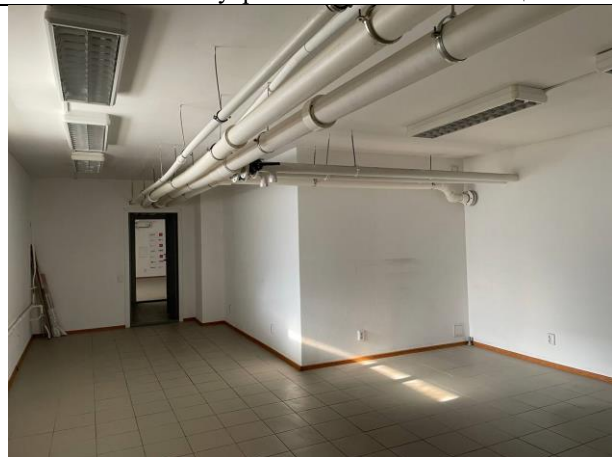
Фото № 16 – Внутреннее состояние помещения
