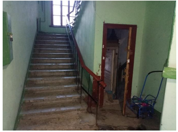
Фото № 8 – Вход в помещение с лестничной клетки
