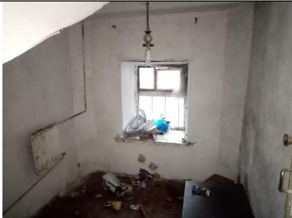
Фото № 9 – Внутреннее состояние помещения
