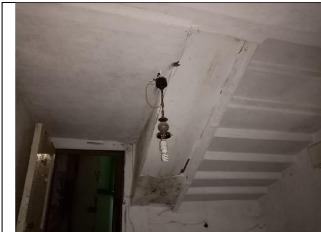
Фото № 13 – Внутреннее состояние помещения
