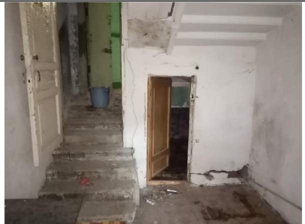
Фото № 10 – Внутреннее состояние помещения
