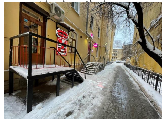
Фото 15. Внутривдворовая территория Объекта оценки
