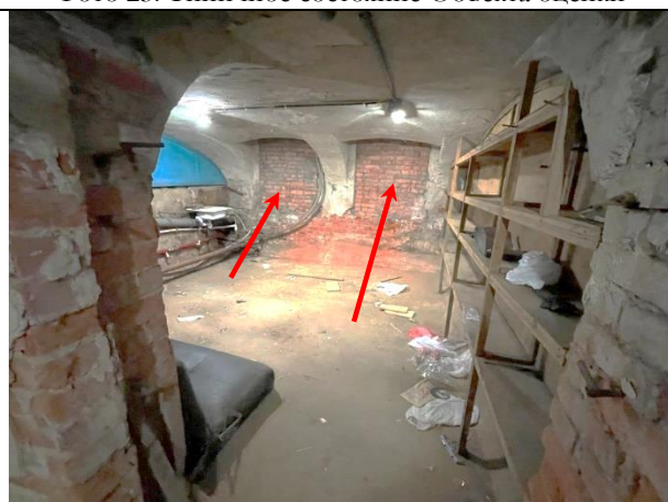
Фото 25. Типичное состояние Объекта оценки, оконная группа Объекта оценки
