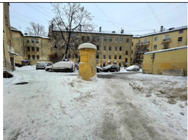
Фото 14. Внутривдворовая территория Объекта оценки
