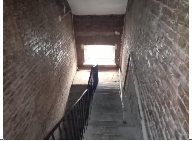
Фото № 8 – Лестничный пролет
