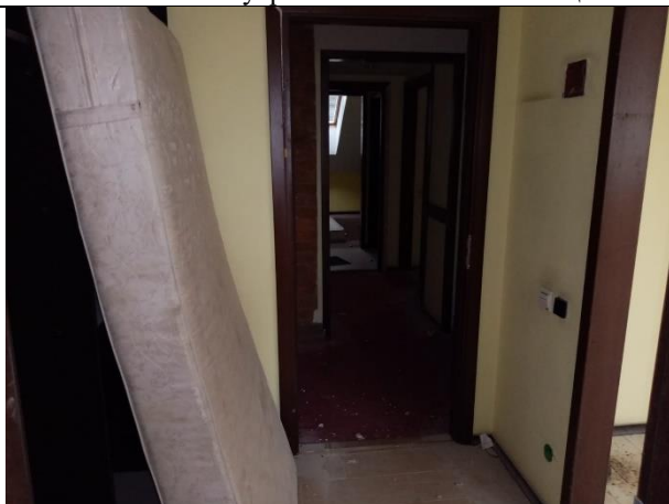
Фото № 19 – Внутреннее состояние помещения
