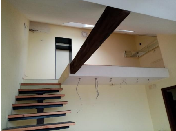
Фото № 15 – Внутреннее состояние помещения
