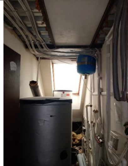
Фото № 10 – Внутреннее состояние помещения
