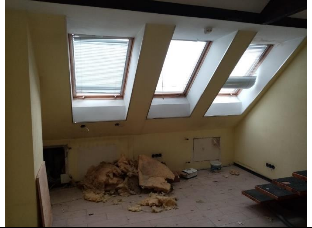
Фото № 14 – Внутреннее состояние помещения
