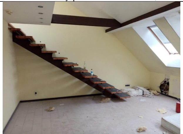
Фото № 18 – Внутреннее состояние помещения
