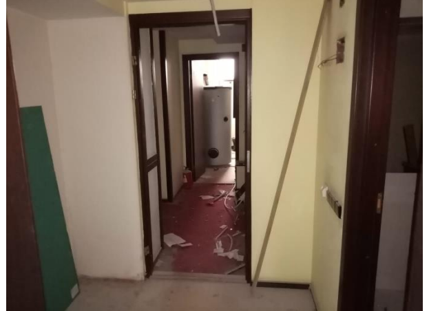
Фото № 16 – Внутреннее состояние помещения
