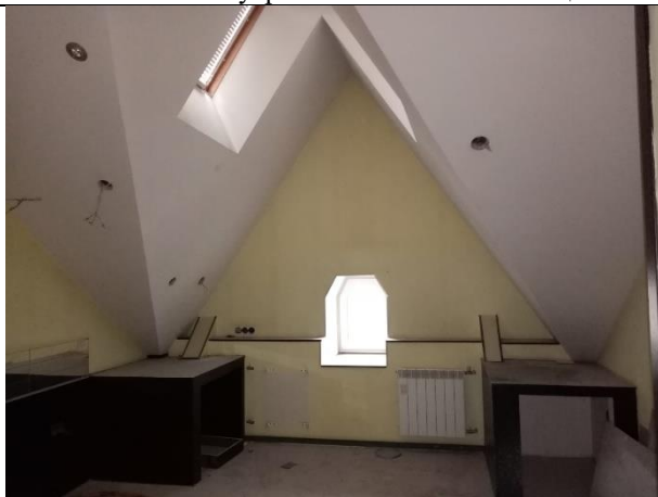
Фото № 17 – Внутреннее состояние помещения
