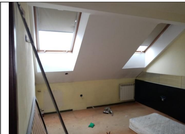
Фото № 22 – Внутреннее состояние помещения
