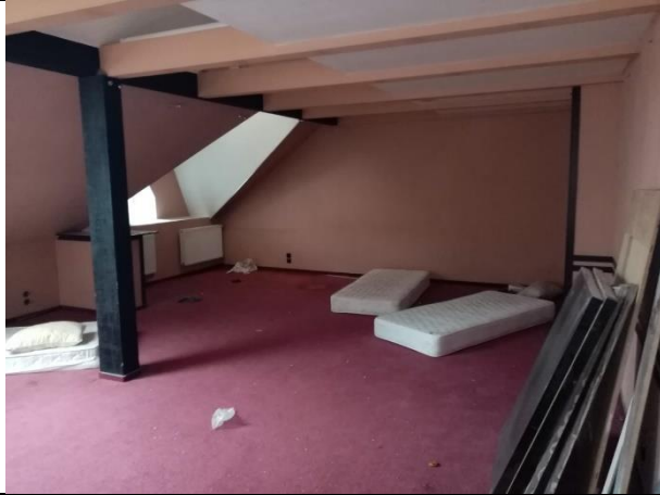
Фото № 13 – Внутреннее состояние помещения
