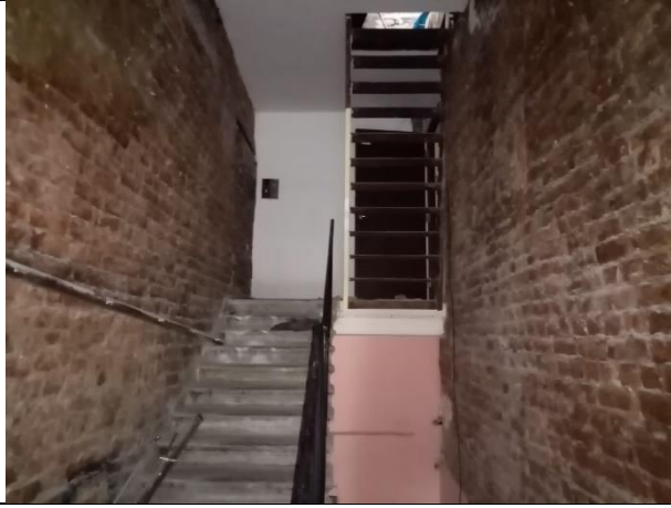
Фото № 7 – Лестничный пролет
