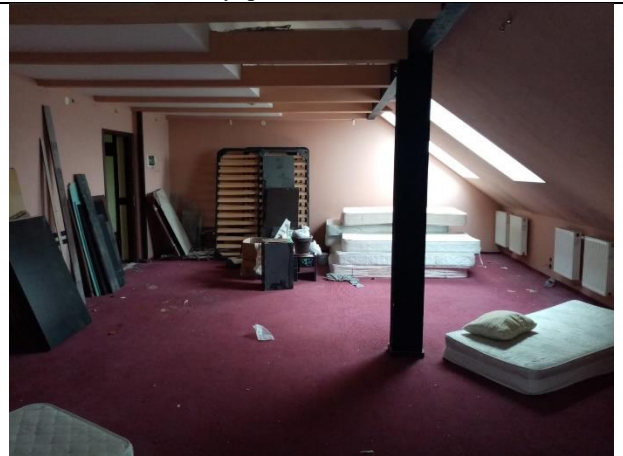
Фото № 12 – Внутреннее состояние помещения
