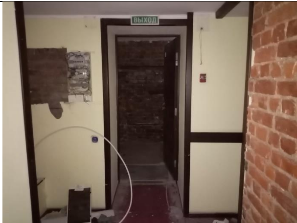
Фото № 11 – Внутреннее состояние помещения
