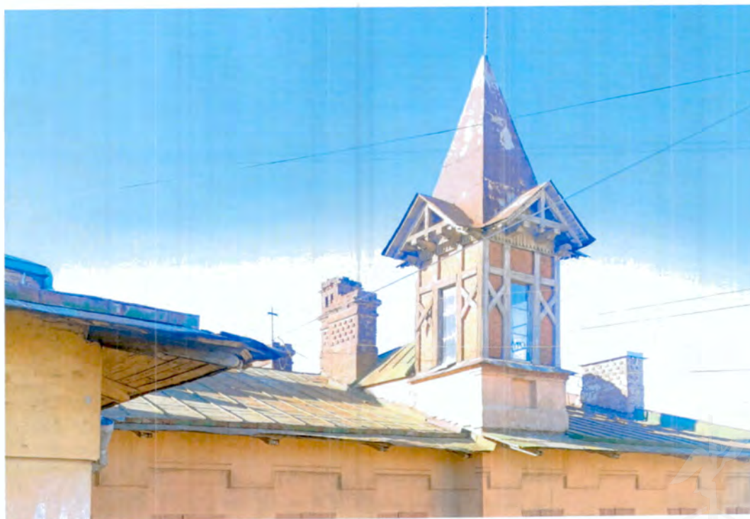
27. Кровля объекта культурного наследия (фото от 05.03.2023).
