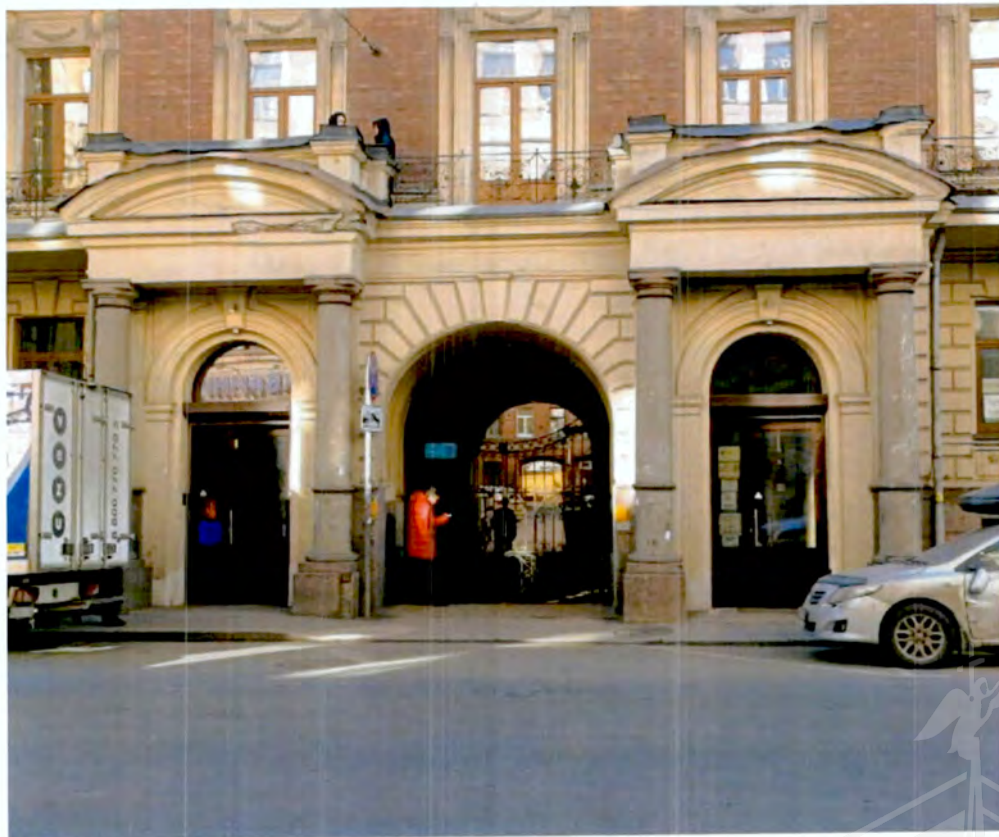
9. Общий вид лицевого фасада объекта культурного наследия (фото от 05.03.2024).
