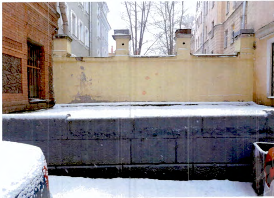
15. Кирпичная оштукатуренная стенка по северо-западной границе участка (фото от 19.04.2024).
