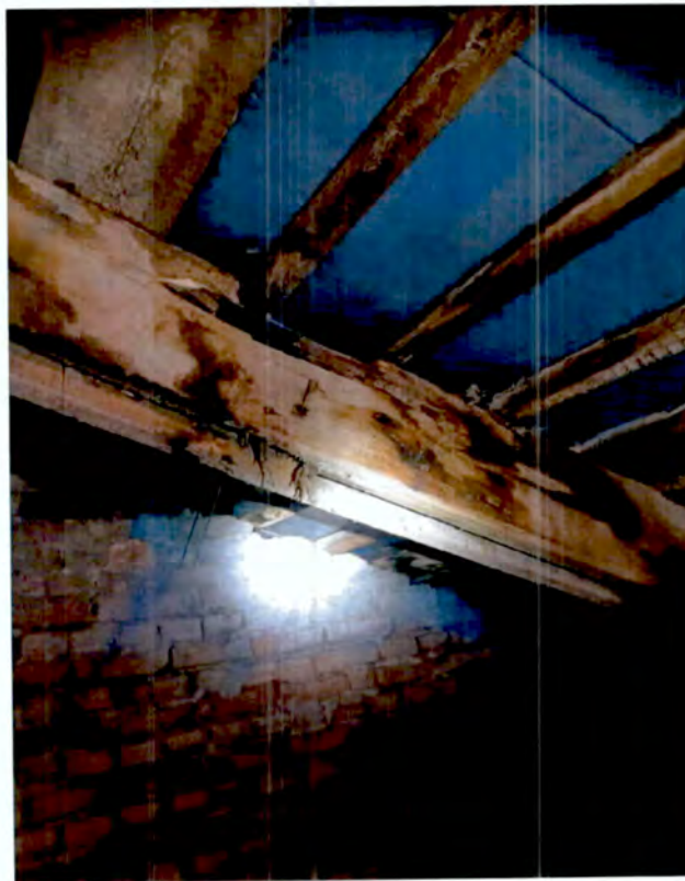
25. Чердачное пространство объекта культурного наследия (фото от 05.03.2024).
