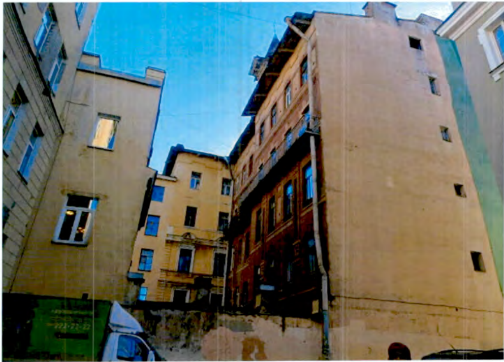
8. Общий вид северо-западного фасада северо-западного флигеля объекта культурного наследия (фото от 05.03.2024).
