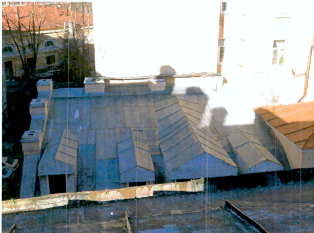
36. Кровля объекта культурного наследия (фото от 05.03.2024).
