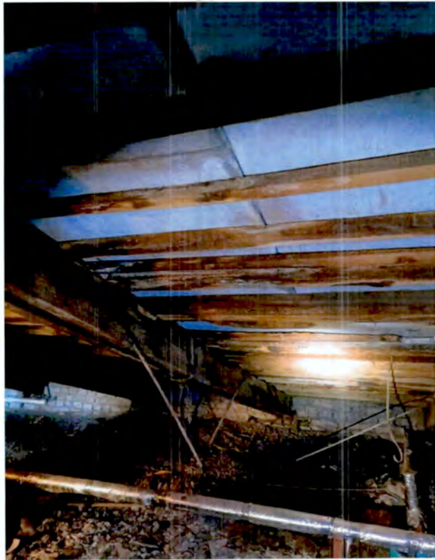
24. Чердачное пространство объекта культурного наследия (фото от 05.03.2024).
