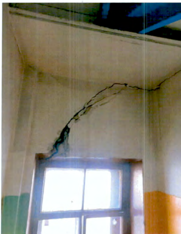
18. Интерьер объекта культурного наследия. Помещение 6ЛК в уровне 4-го этажа (фото от 05.03.2024).
