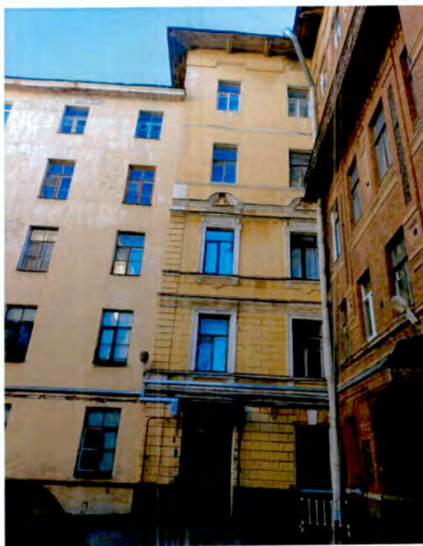
11. Фрагмент северо-западного фасада юго-восточного флигеля объекта культурного наследия (фото от 05.03.2024).
