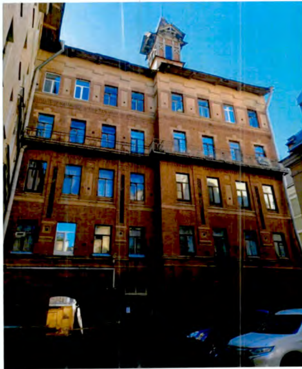
3. Общий вид северо-восточного фасада юго-западного флигеля объекта культурного наследия (фото от 05.03.2024).
