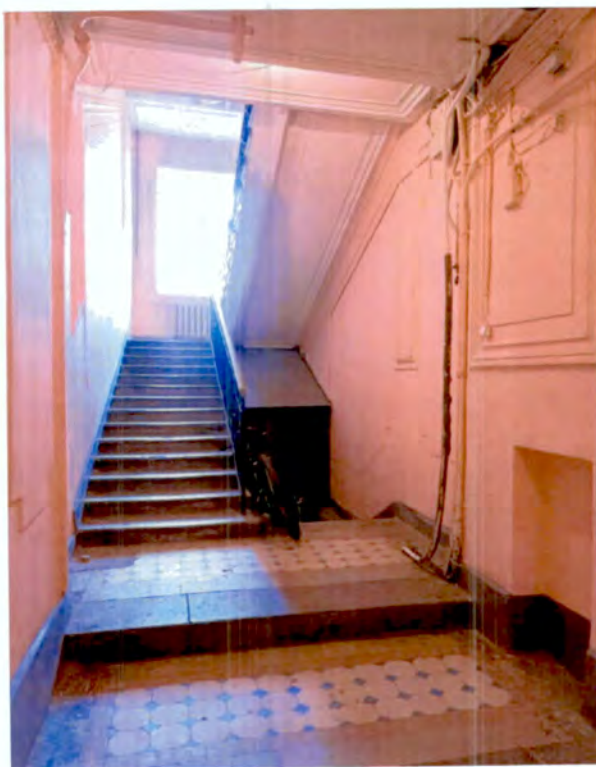
17. Интерьер объекта культурного наследия. Помещение 7ЛК в уровне 1-го этажа (фото от 05.03.2024).
