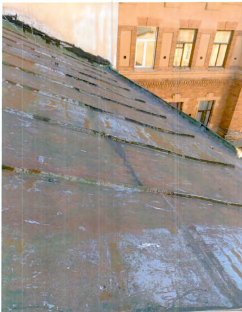
28. Кровля объекта культурного наследия (фото от 05.03.2023).
