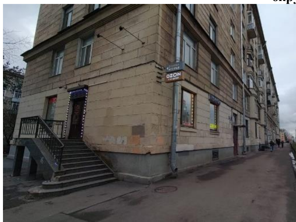
Фото 1. Вид здания Объекта оценки, с улицы
