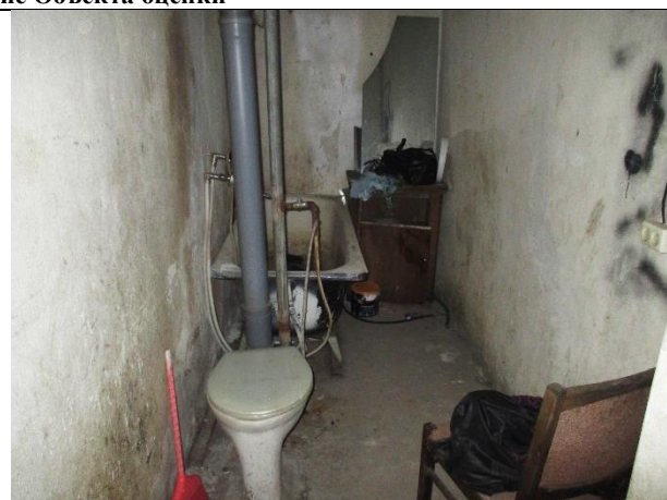
Фото 8. Внутреннее состояние Объекта оценки
