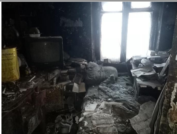
Фото № 23. Внутреннее состояние здания
