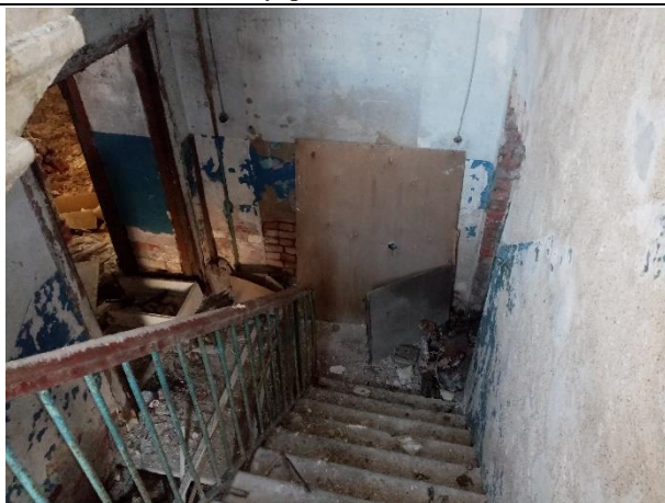
Фото № 21. Внутреннее состояние здания
