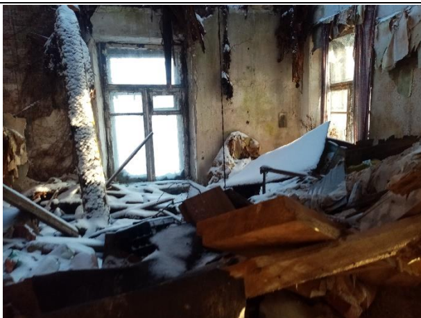
Фото № 25. Внутреннее состояние здания
