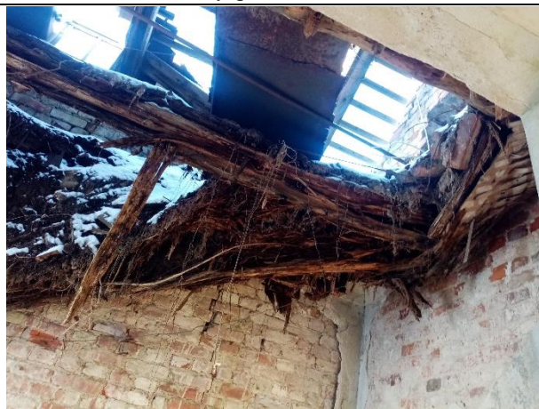
Фото № 30. Внутреннее состояние здания
