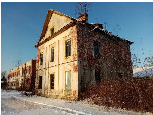
Фото № 7. Внешний вид здания и земельного участка
