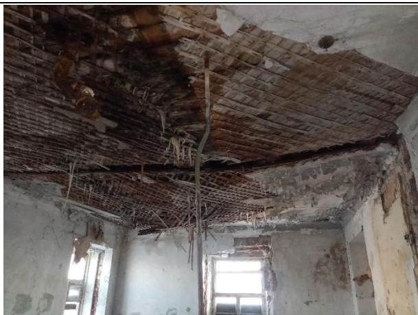
Фото № 13. Внутреннее состояние здания
