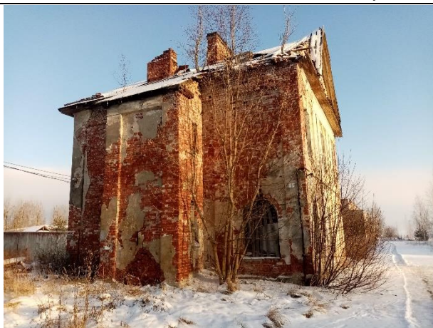
Фото № 9. Внешний вид здания и земельного участка
