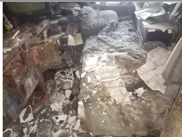
Фото № 24. Внутреннее состояние здания
