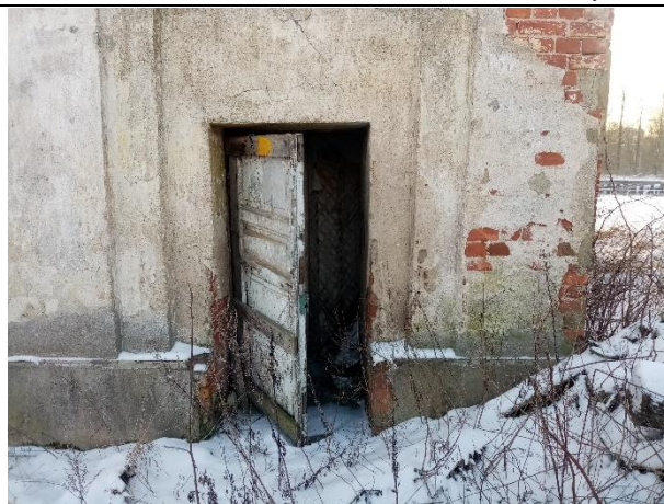
Фото № 10. Вход в здание
