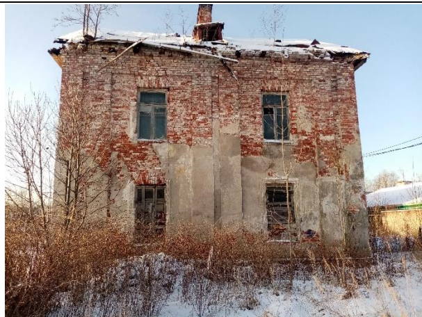
Фото № 8. Внешний вид здания и земельного участка
