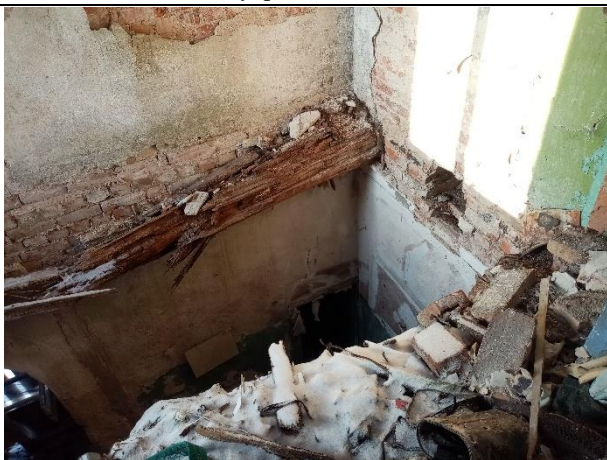
Фото № 29. Внутреннее состояние здания
