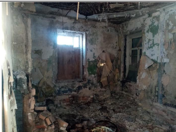
Фото № 14. Внутреннее состояние здания
