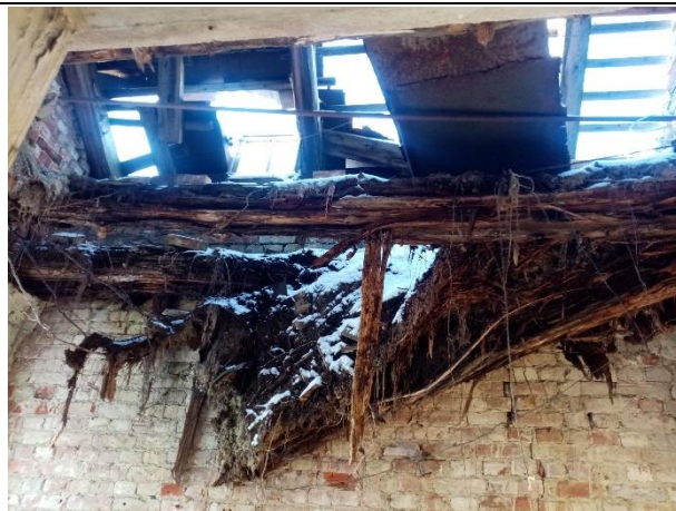
Фото № 28. Внутреннее состояние здания
