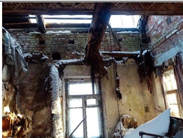
Фото № 26. Внутреннее состояние здания
