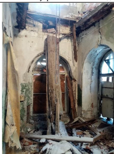
Фото № 18. Внутреннее состояние здания
