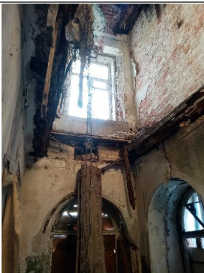
Фото № 19. Внутреннее состояние здания
