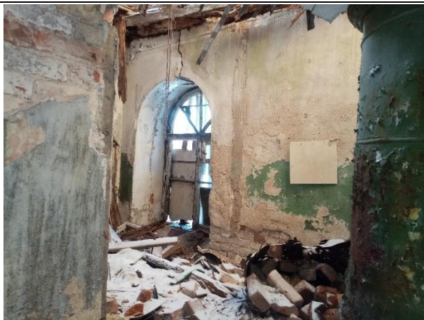
Фото № 15. Внутреннее состояние здания
