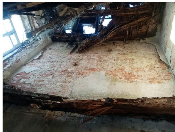
Фото № 20. Внутреннее состояние здания
