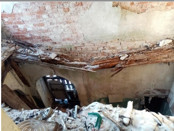
Фото № 27. Внутреннее состояние здания
