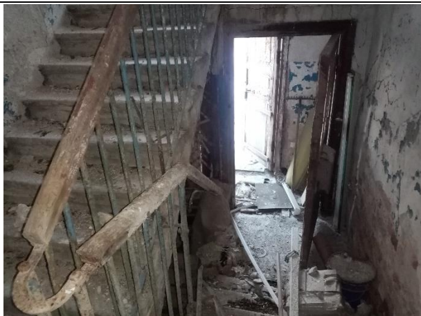
Фото № 11. Вход в здание
