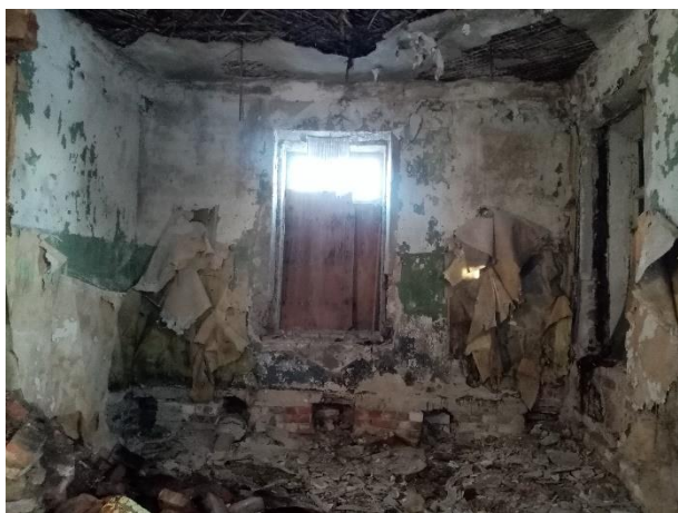
Фото № 17. Внутреннее состояние здания
