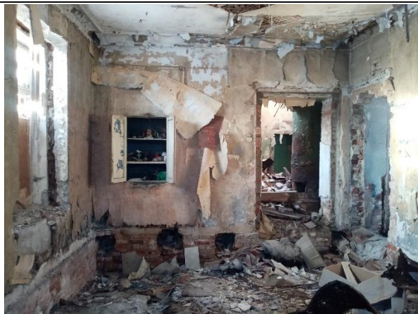
Фото № 16. Внутреннее состояние здания
