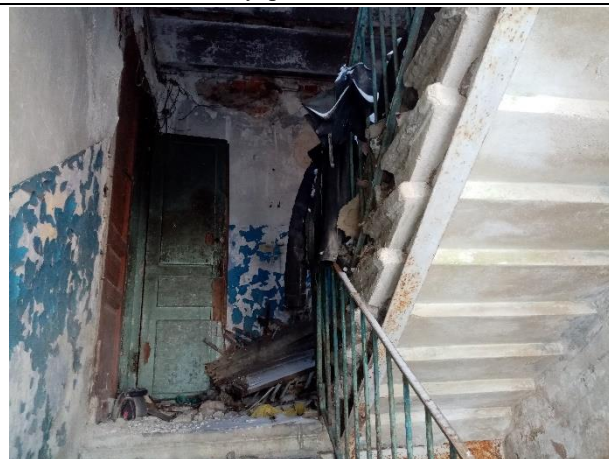
Фото № 22. Внутреннее состояние здания
