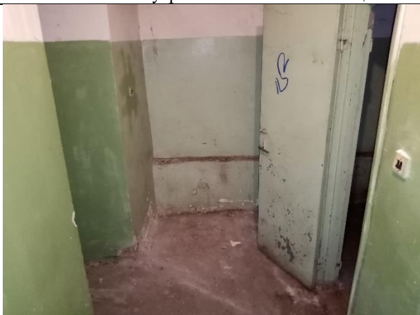
Фото № 13 – Внутреннее состояние помещения
