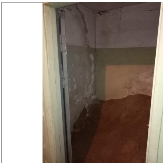
Фото № 15 – Внутреннее состояние помещения
