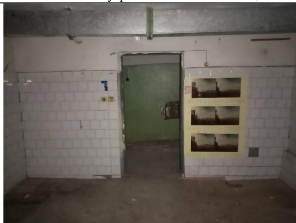
Фото № 20 – Внутреннее состояние помещения
