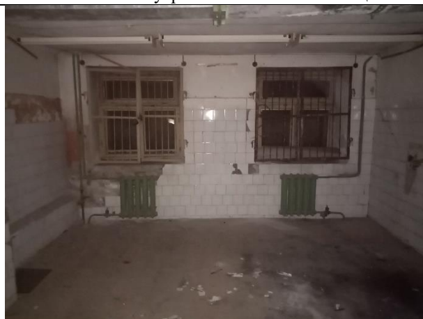
Фото № 18 – Внутреннее состояние помещения
