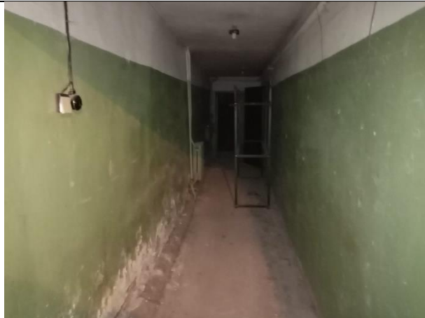
Фото № 21 – Внутреннее состояние помещения
