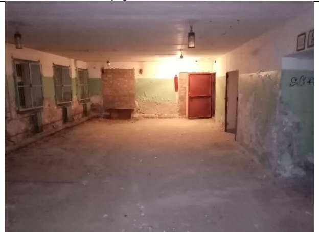
Фото № 10 – Внутреннее состояние помещения
