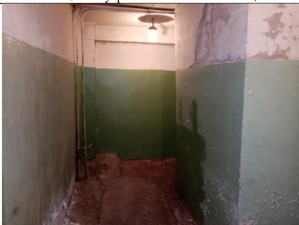
Фото № 11 – Внутреннее состояние помещения
