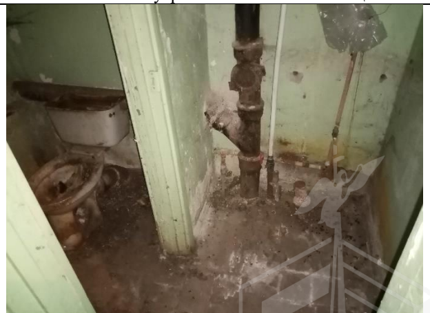
Фото № 14 – Внутреннее состояние помещения
