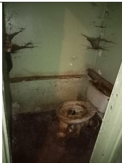
Фото № 16 – Внутреннее состояние помещения
