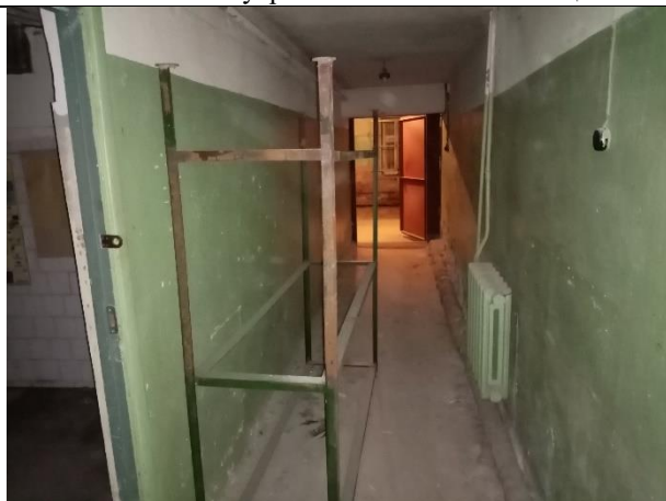
Фото № 19 – Внутреннее состояние помещения
