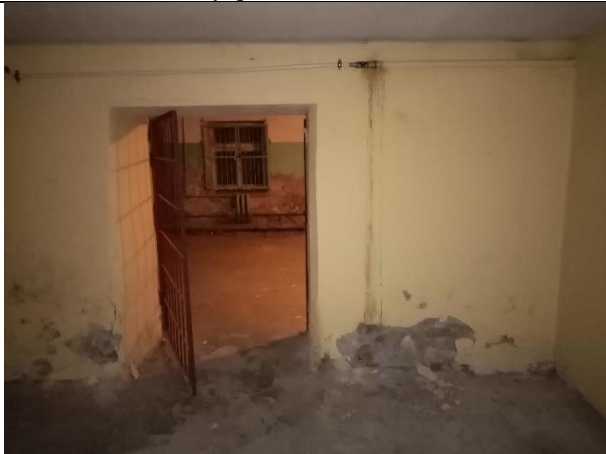
Фото № 9 – Внутреннее состояние помещения
