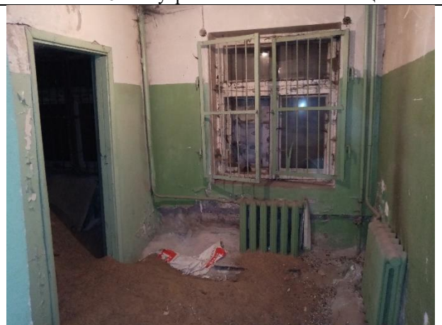
Фото № 12 – Внутреннее состояние помещения
