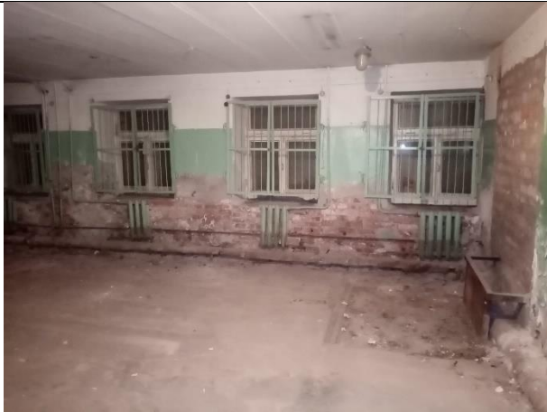
Фото № 7 – Внутреннее состояние помещения
