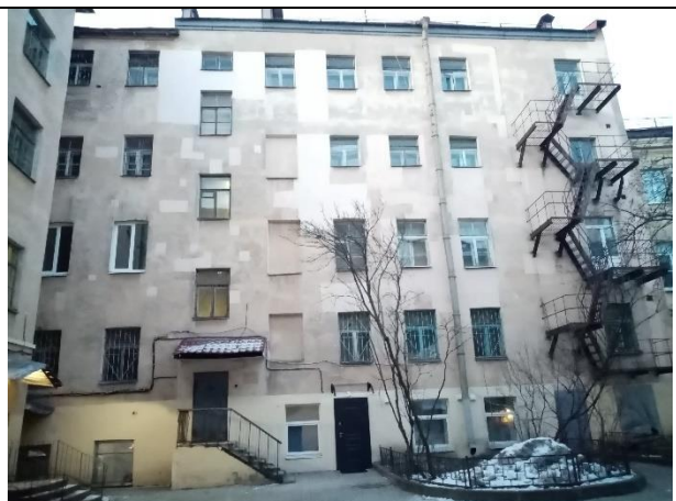
Фото № 2 – Здание, в котором находится Объект оценки
