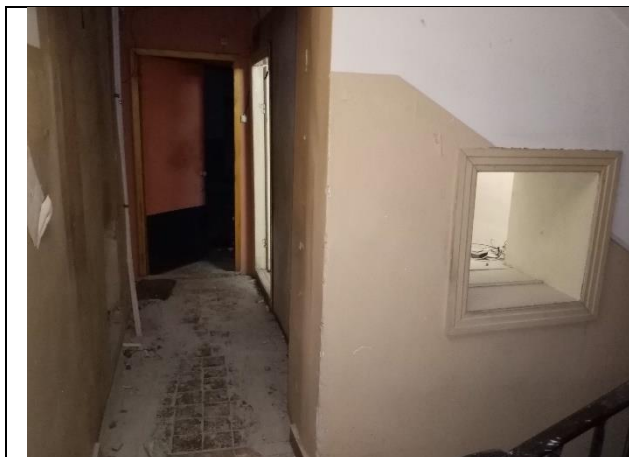
Фото № 5 – Вход в помещение
