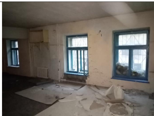
Фото № 6 – Внутреннее состояние помещения
