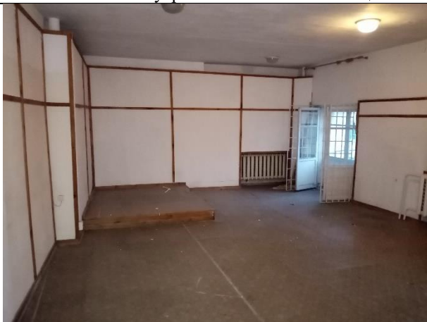
Фото № 15 – Внутреннее состояние помещения
