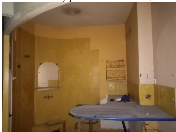
Фото № 8 – Внутреннее состояние помещения
