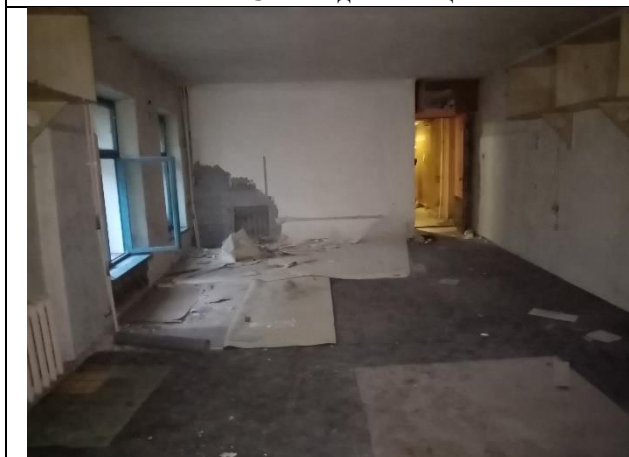
Фото № 7 – Внутреннее состояние помещения
