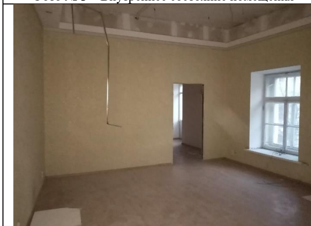
Фото № 11 – Внутреннее состояние помещения
