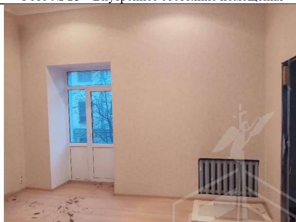
Фото № 12 – Внутреннее состояние помещения
