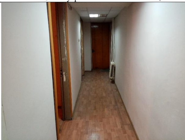
Фото № 17 – Внутреннее состояние помещения
