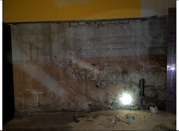
Фото № 34 – Внутреннее состояние помещения 9-Н
