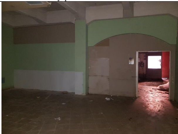
Фото № 37 – Внутреннее состояние помещения 9-Н
