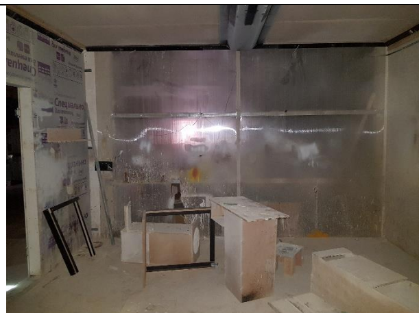
Фото № 58 – Внутреннее состояние помещения 11-Н
