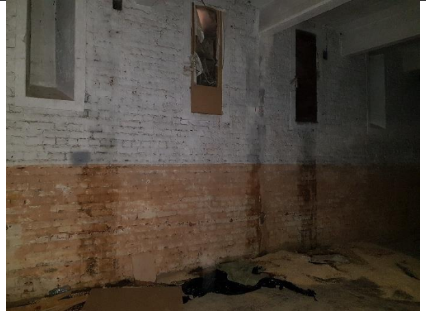
Фото № 44 – Внутреннее состояние помещения 9-Н
