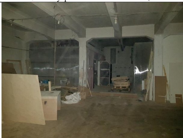
Фото № 53 – Внутреннее состояние помещения 11-Н
