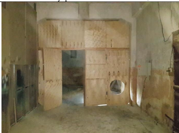
Фото № 39 – Внутреннее состояние помещения 9-Н
