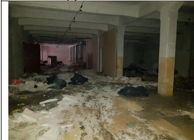
Фото № 23 – Внутреннее состояние помещения 2-Н
