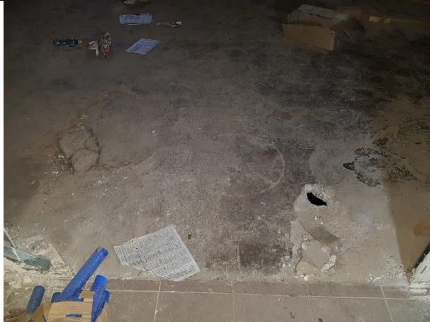
Фото № 43 – Внутреннее состояние помещения 9-Н
