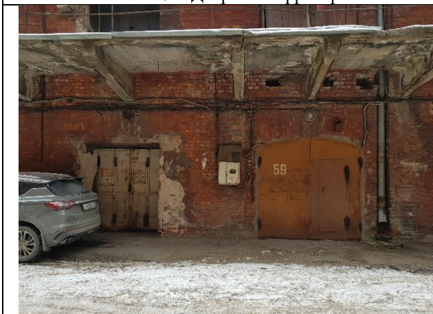
Фото № 11 – Вход в помещение 2-Н
