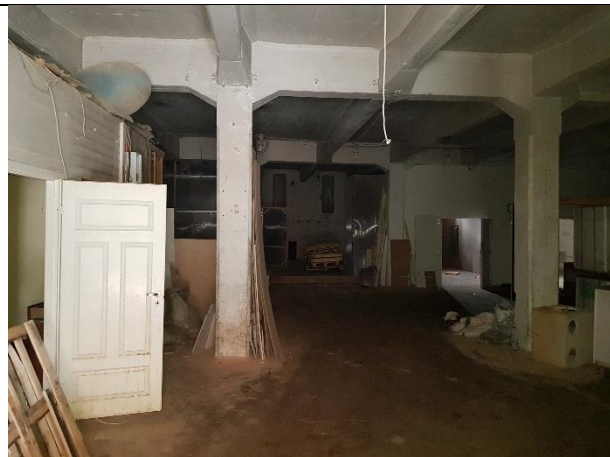
Фото № 50 – Внутреннее состояние помещения 11-Н
