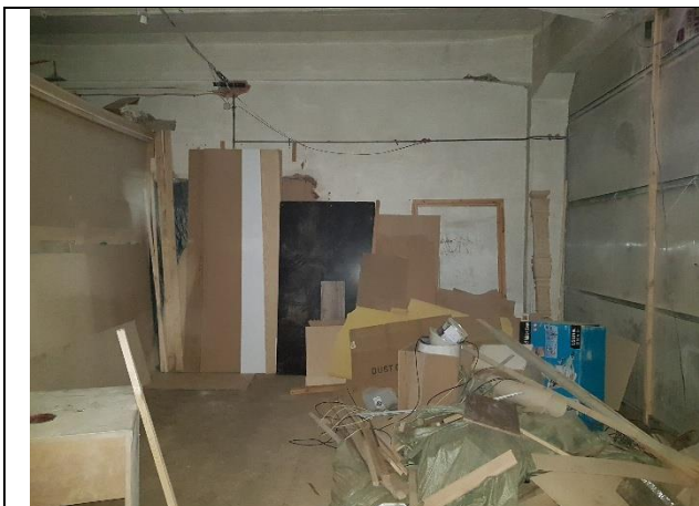
Фото № 57 – Внутреннее состояние помещения 11-Н
