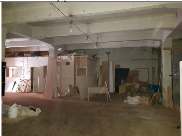
Фото № 55 – Внутреннее состояние помещения 11-Н
