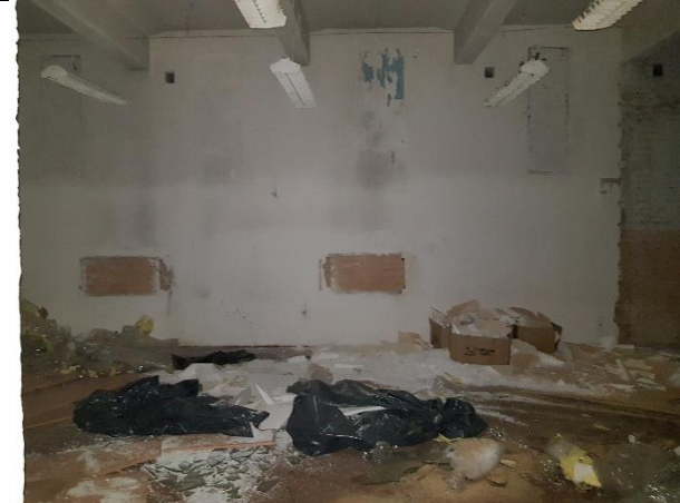
Фото № 28 – Внутреннее состояние помещения 2-Н
