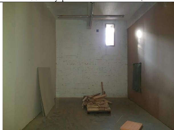
Фото № 60 – Внутреннее состояние помещения 11-Н
