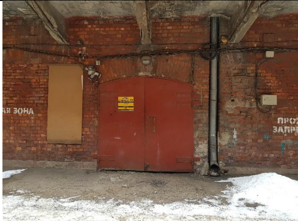
Фото № 31 – Вход в помещение 9-Н
