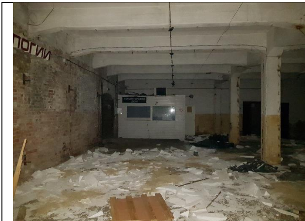
Фото № 17 – Внутреннее состояние помещения 2-Н
