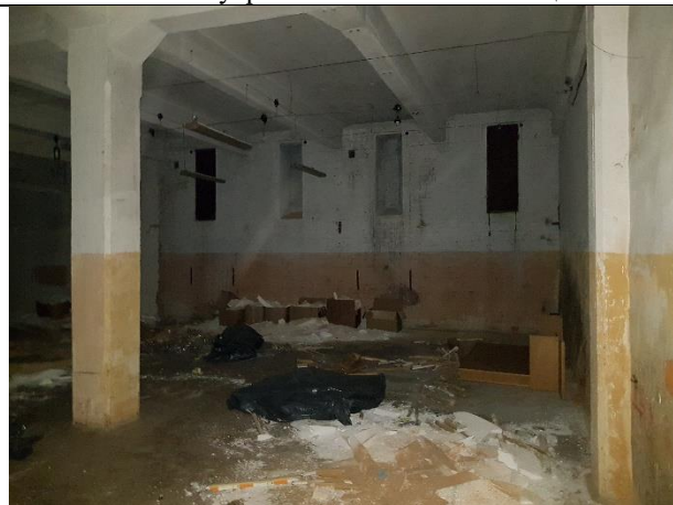
Фото № 22 – Внутреннее состояние помещения 2-Н
