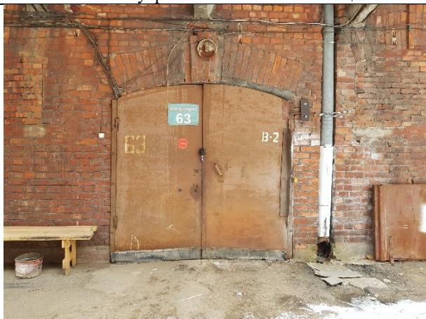
Фото № 47 – Вход в помещение 11-Н
