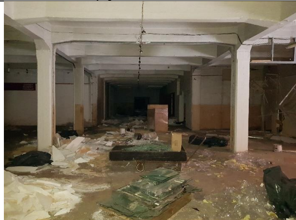
Фото № 30 – Внутреннее состояние помещения 2-Н
