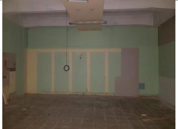
Фото № 36 – Внутреннее состояние помещения 9-Н
