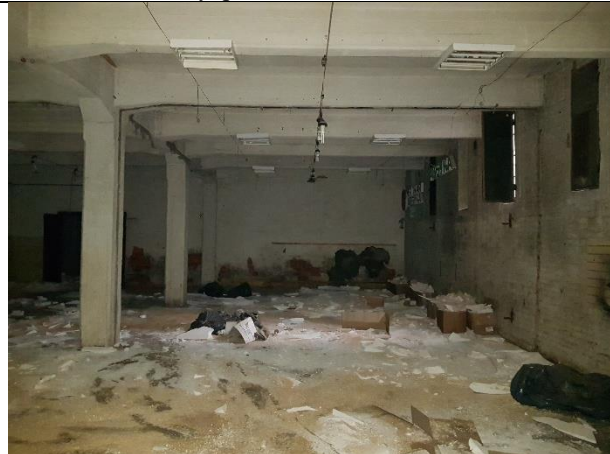
Фото № 20 – Внутреннее состояние помещения 2-Н
