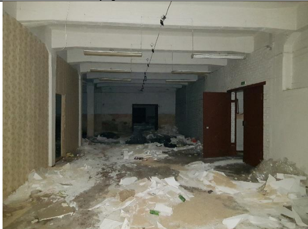
Фото № 29 – Внутреннее состояние помещения 2-Н
