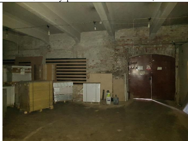
Фото № 54 – Внутреннее состояние помещения 11-Н
