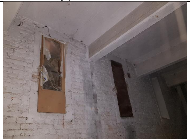
Фото № 46 – Внутреннее состояние помещения 9-Н
