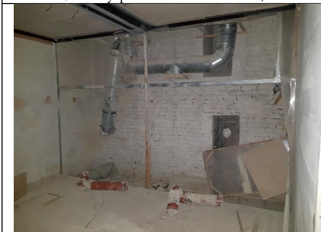
Фото № 59 – Внутреннее состояние помещения 11-Н
