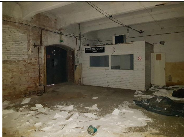
Фото № 18 – Внутреннее состояние помещения 2-Н
