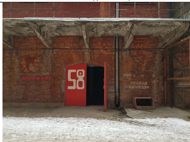
Фото № 12 – Вход в помещение 2-Н
