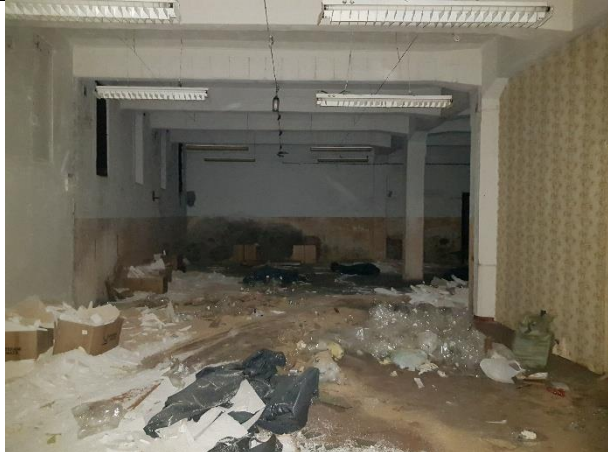
Фото № 27 – Внутреннее состояние помещения 2-Н
