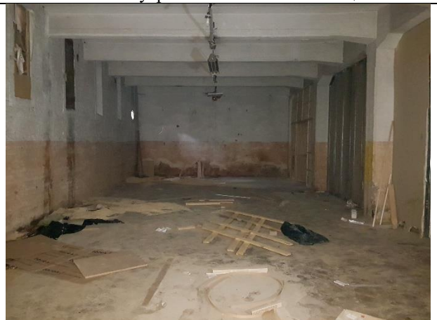
Фото № 38 – Внутреннее состояние помещения 9-Н
