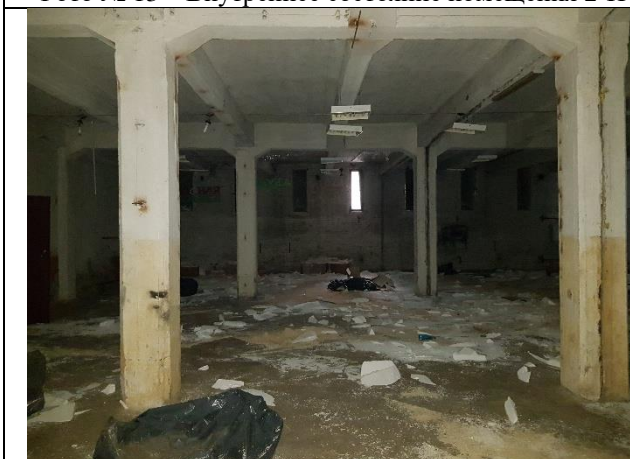
Фото № 15 – Внутреннее состояние помещения 2-Н
