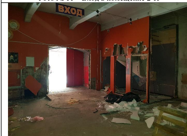
Фото № 13 – Внутреннее состояние помещения 2-Н
