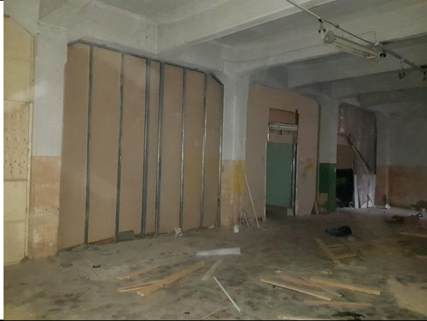
Фото № 41 – Внутреннее состояние помещения 9-Н
