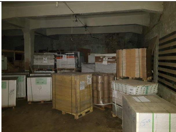
Фото № 49 – Внутреннее состояние помещения 11-Н
