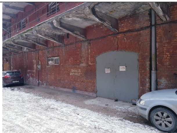
Фото № 10 – Вход в помещение 2-Н
