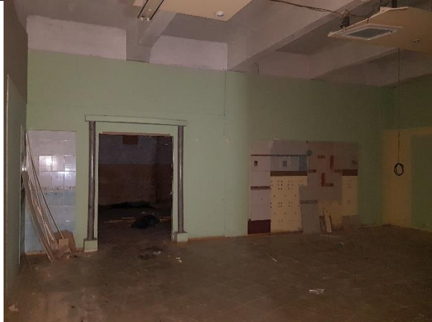
Фото № 35 – Внутреннее состояние помещения 9-Н
