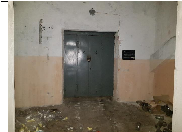
Фото № 25 – Внутреннее состояние помещения 2-Н
