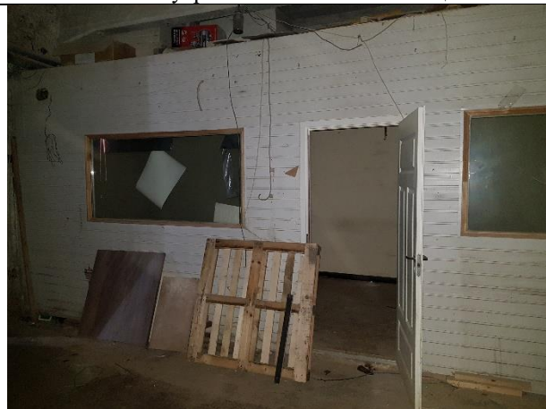
Фото № 52 – Внутреннее состояние помещения 11-Н
