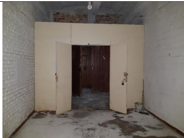
Фото № 26 – Внутреннее состояние помещения 2-Н
