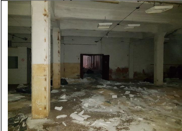
Фото № 19 – Внутреннее состояние помещения 2-Н
