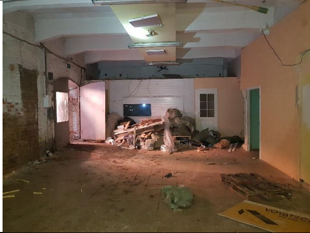
Фото № 33 – Внутреннее состояние помещения 9-Н
