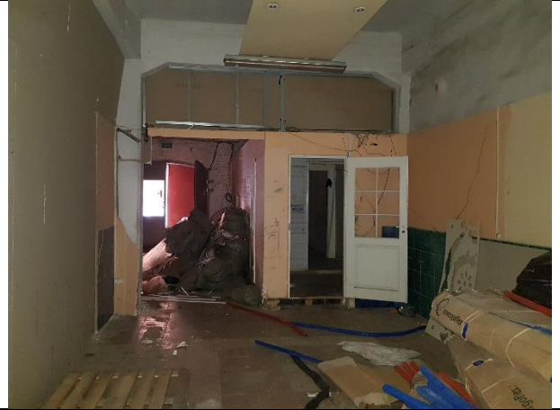
Фото № 42 – Внутреннее состояние помещения 9-Н
