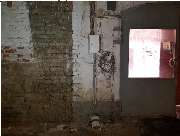
Фото № 45 – Внутреннее состояние помещения 9-Н
