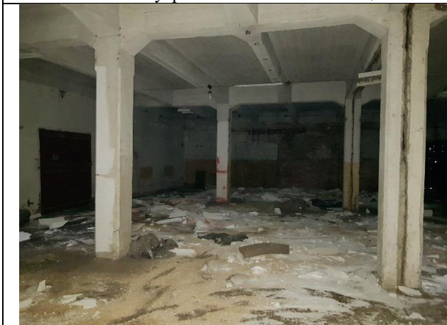
Фото № 21 – Внутреннее состояние помещения 2-Н
