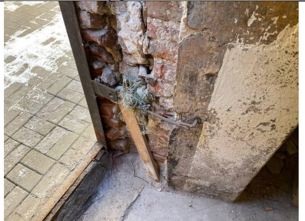
Фото № 14 – Внутреннее состояние помещения
