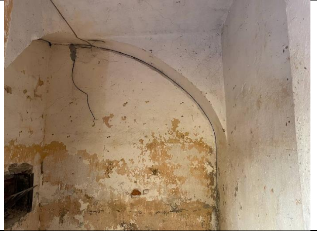
Фото № 12 – Внутреннее состояние помещения
