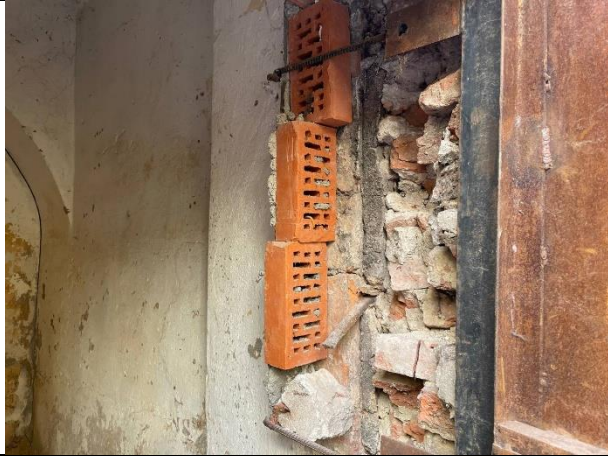
Фото № 11 – Внутреннее состояние помещения
