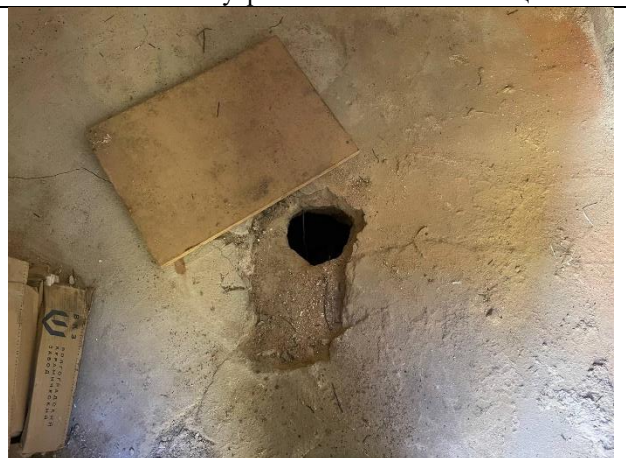
Фото № 16 – Внутреннее состояние помещения
