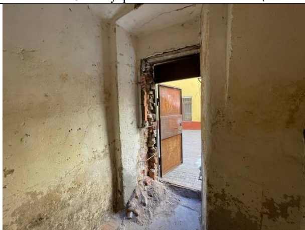
Фото № 15 – Внутреннее состояние помещения
