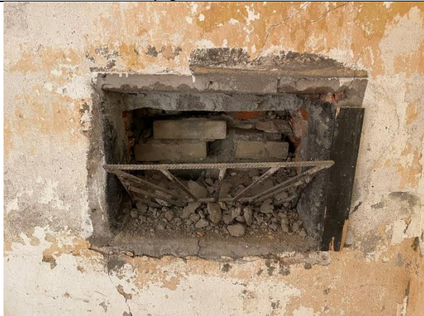
Фото № 13 – Внутреннее состояние помещения
