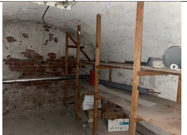
Фото № 22 – Внутреннее состояние помещения
