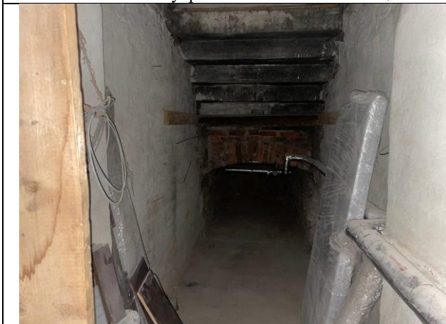
Фото № 21 – Внутреннее состояние помещения
