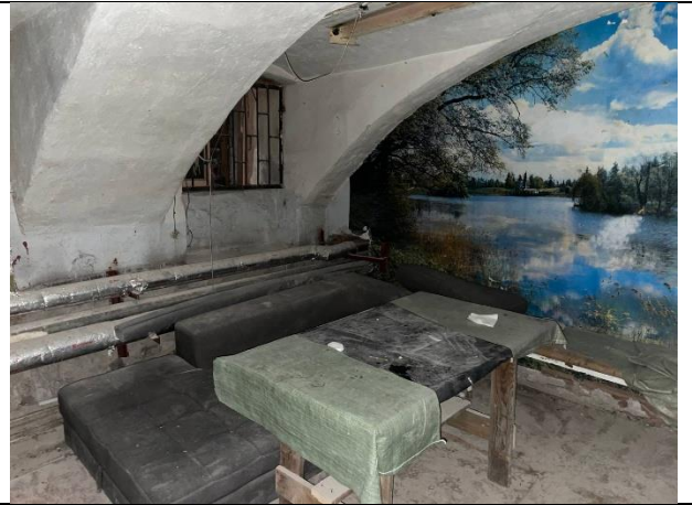
Фото № 12 – Внутреннее состояние помещения
