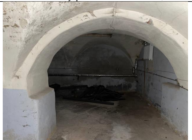
Фото № 16 – Внутреннее состояние помещения
