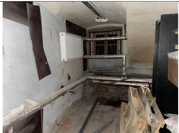
Фото № 28 – Внутреннее состояние помещения
