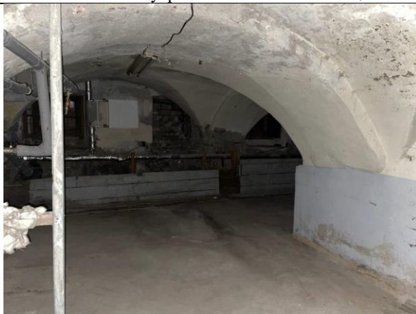
Фото № 15 – Внутреннее состояние помещения
