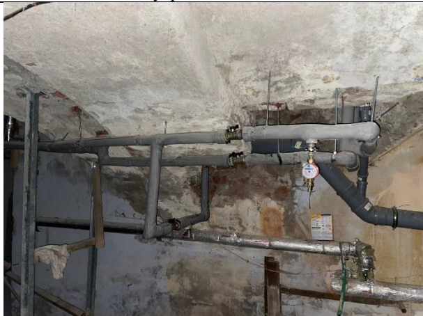
Фото № 17 – Внутреннее состояние помещения
