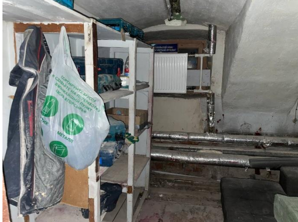
Фото № 13 – Внутреннее состояние помещения
