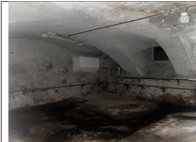
Фото № 19 – Внутреннее состояние помещения
