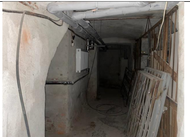
Фото № 20 – Внутреннее состояние помещения
