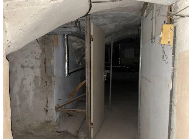
Фото № 14 – Внутреннее состояние помещения
