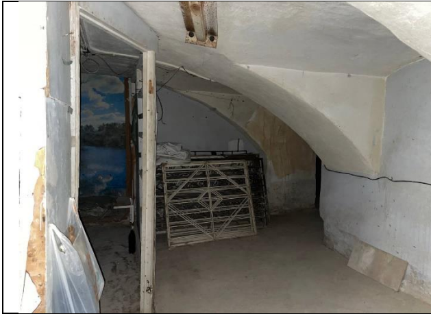
Фото № 11 – Внутреннее состояние помещения
