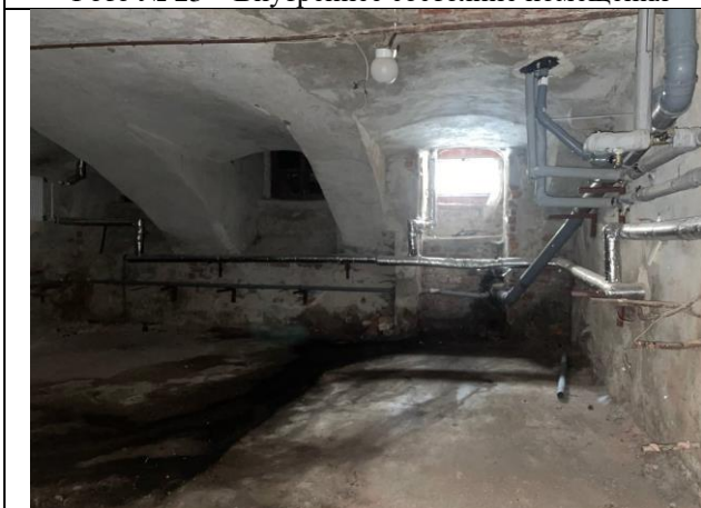
Фото № 25 – Внутреннее состояние помещения
