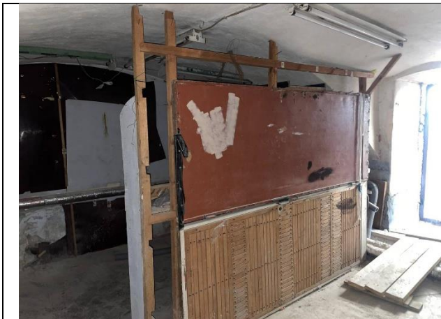
Фото № 27 – Внутреннее состояние помещения
