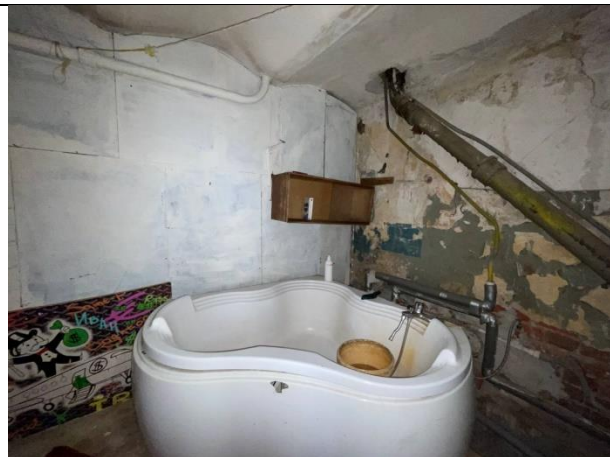
Фото № 14 – Внутреннее состояние помещения
