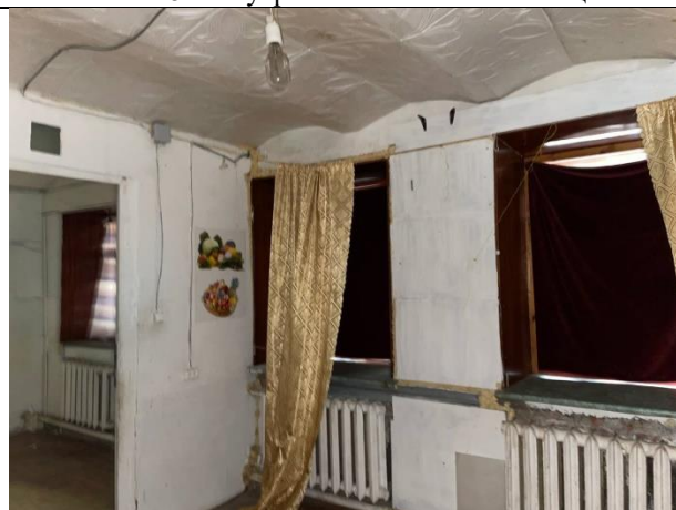
Фото № 18 – Внутреннее состояние помещения
