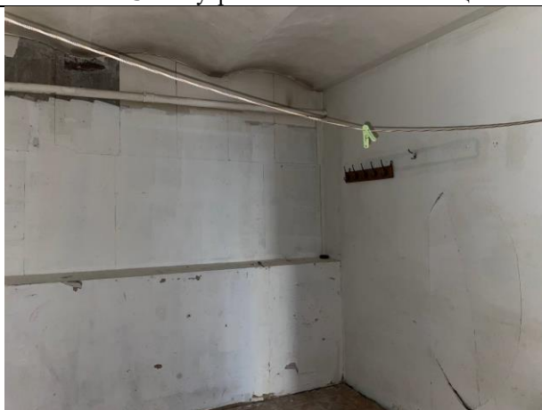
Фото № 17 – Внутреннее состояние помещения
