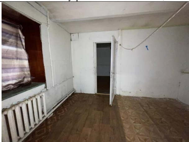
Фото № 15 – Внутреннее состояние помещения
