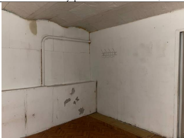
Фото № 19 – Внутреннее состояние помещения
