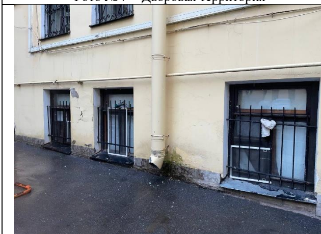
Фото № 9 – Окна помещения
