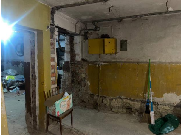
Фото № 15 – Внутреннее состояние помещения
