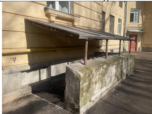
Фото № 8 – Отдельный вход в помещение
