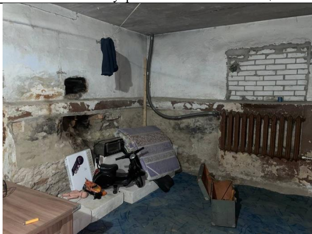
Фото № 19 – Внутреннее состояние помещения
