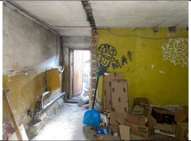
Фото № 14 – Внутреннее состояние помещения
