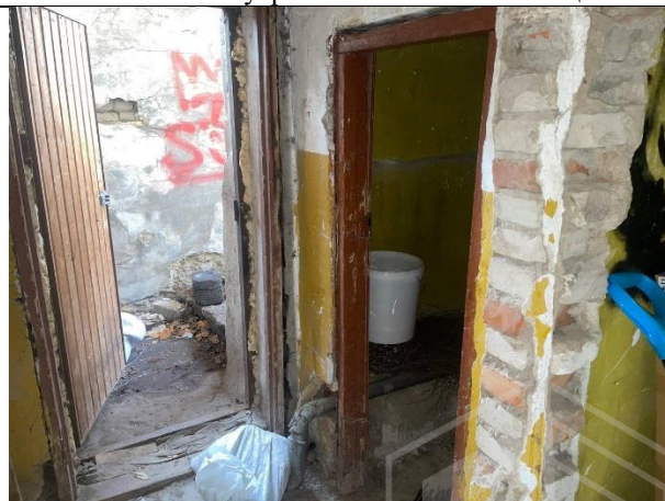
Фото № 12 – Внутреннее состояние помещения
