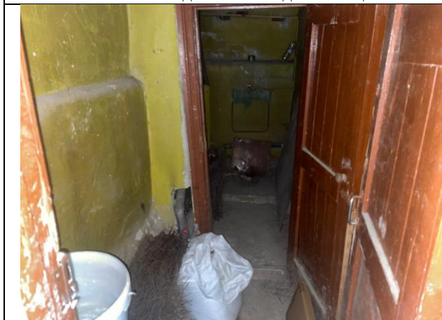
Фото № 11 – Внутреннее состояние помещения
