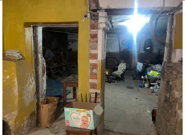
Фото № 16 – Внутреннее состояние помещения
