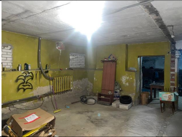
Фото № 13 – Внутреннее состояние помещения
