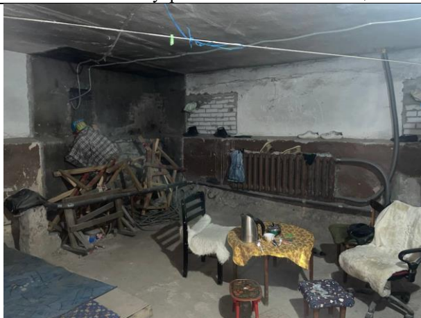
Фото № 17 – Внутреннее состояние помещения
