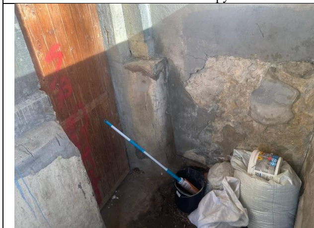
Фото № 9 – Отдельный вход в помещение
