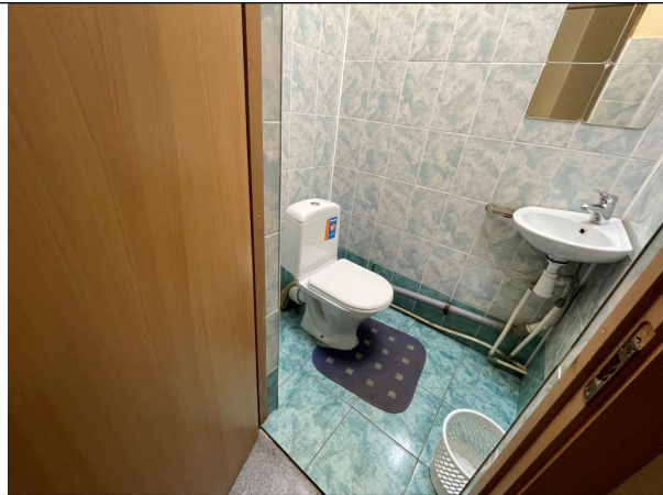
Фото 57. Типичное состояние Объекта оценки
