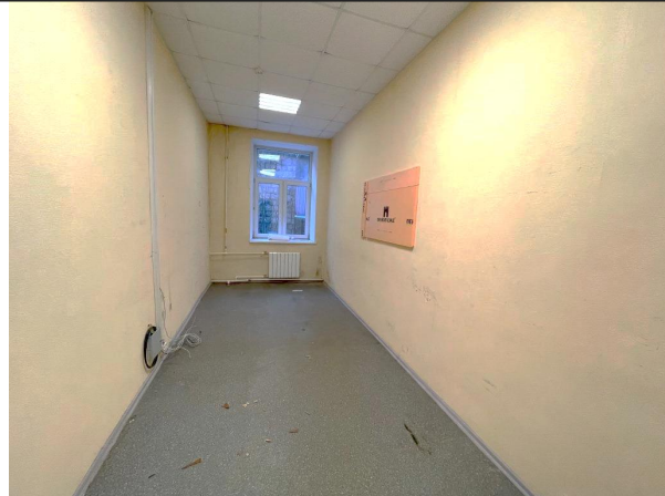
Фото 49. Типичное состояние Объекта оценки
