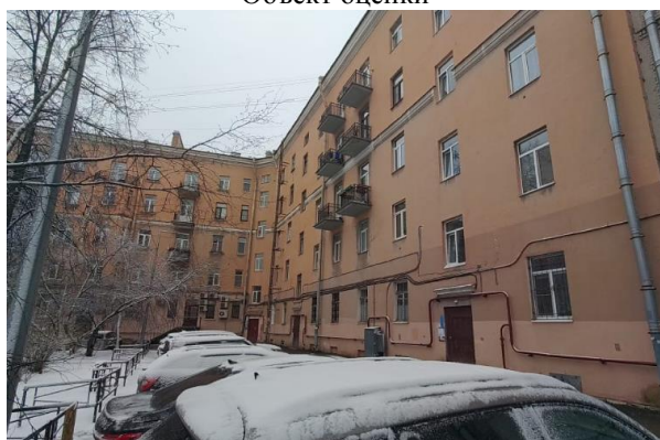
Фото 3. Вид здания, в котором расположен Объект оценки
