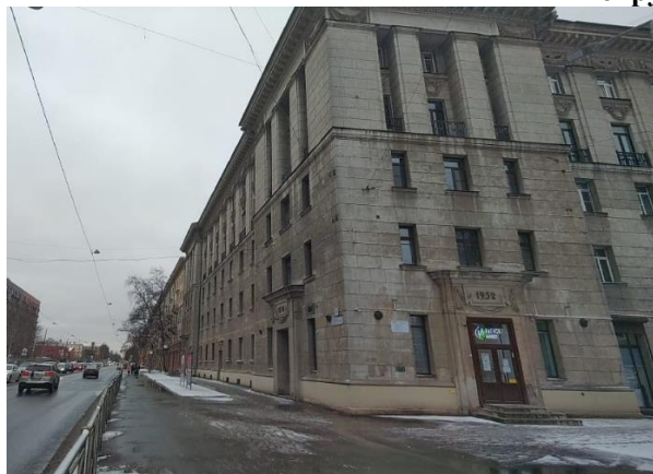
Фото 1. Вид здания, в котором расположен Объект оценки
