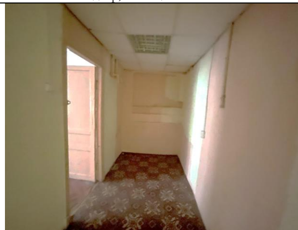
Фото 25. Типичное состояние Объекта оценки, помещение 4-Н
