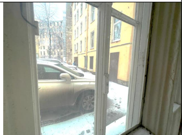
Фото 16. Оконная группа Объекта оценки, окна во двор, помещение 4-Н
