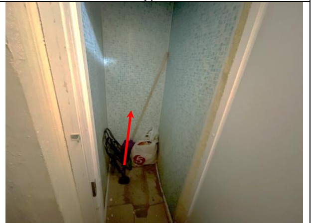
Фото 14. Типичное состояние Объекта оценки, помещение 3-Н
