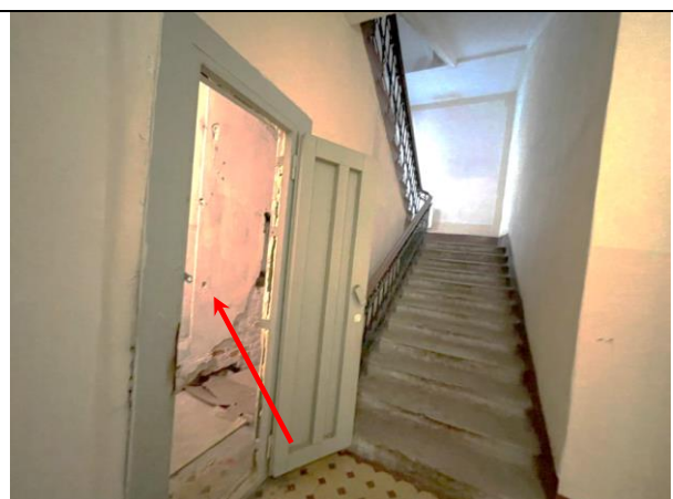
Фото 10. Входная группа Объекта оценки, лестничный проём Объекта оценки, помещение под лестничным проёмом
