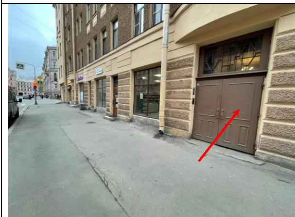
Фото 7. Ближайшее окружение Объекта оценки, входная группа Объекта оценки (вход с Перекупного переулка)
