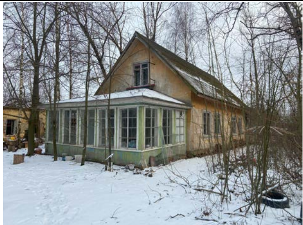
Фото № 5. Внешний вид здания литеры А
