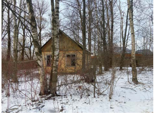
Фото № 11. Внешний вид здания литеры В
