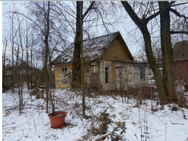
Фото № 13. Внешний вид здания литеры Е
