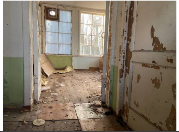
Фото № 10. Внутреннее состояние здание литеры Б
