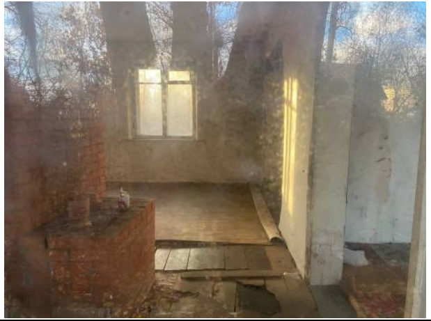
Фото № 9. Внутреннее состояние здание литеры Б
