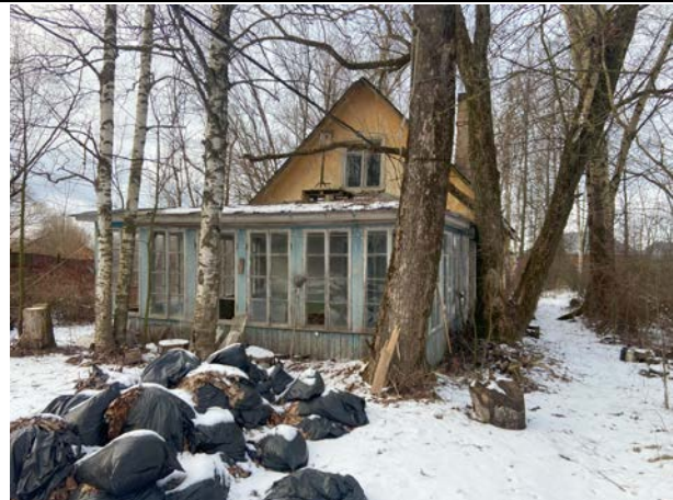
Фото № 6. Внешний вид здания литеры А
