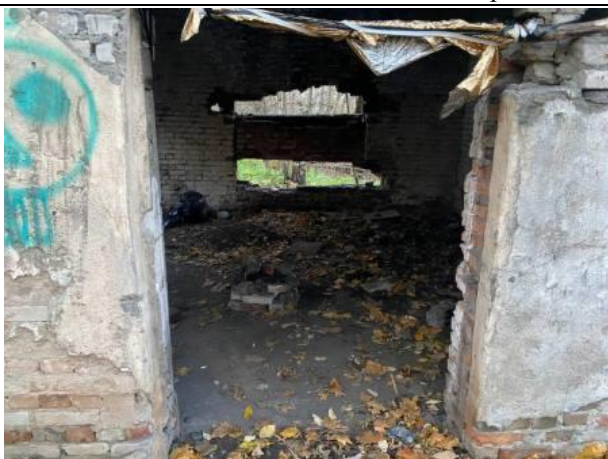
Фото № 5. Внешний вид здания литера Д
