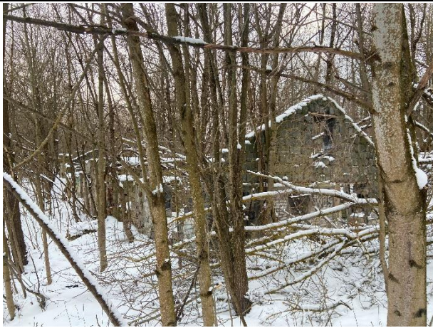
Фото № 3. Внешний вид здания литера З
