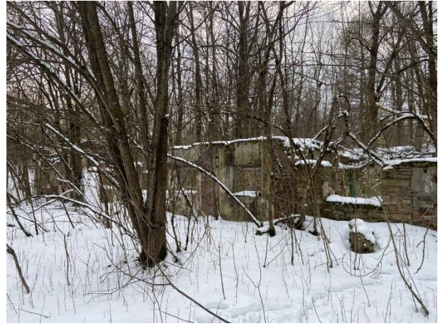
Фото № 10. Внешний вид здания литеры А
