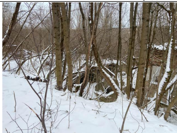
Фото № 6. Внешний вид здания литера Ж
