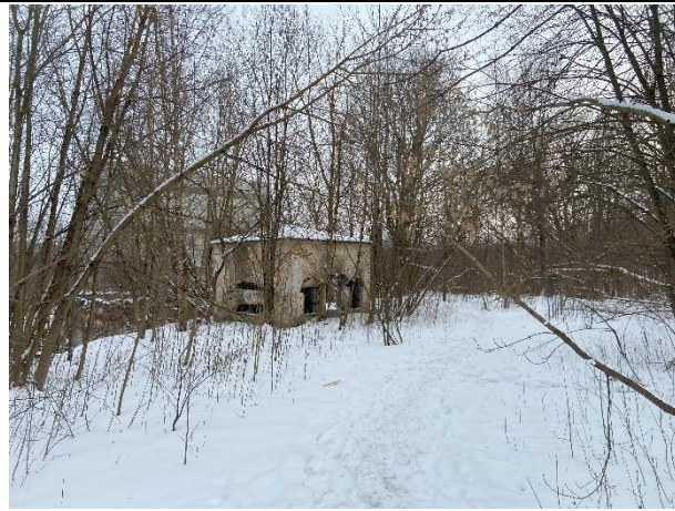
Фото № 4. Внешний вид здания литера Д
