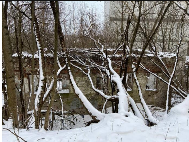
Фото № 11. Внешний вид здания литеры А
