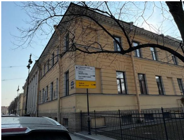
Фото 1. Вид здания Объекта оценки
