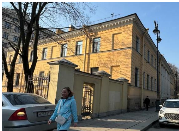
Фото 3. Вид здания Объекта оценки
