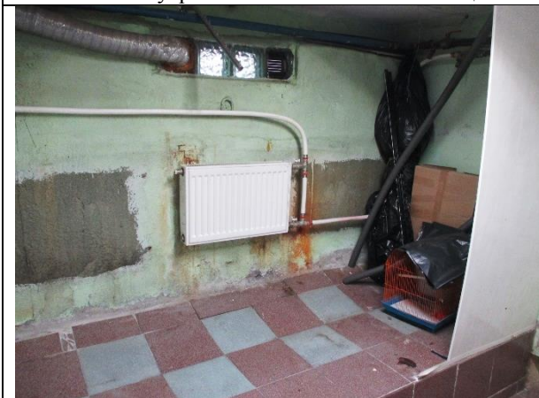
Фото 15. Внутреннее состояние Объекта оценки
