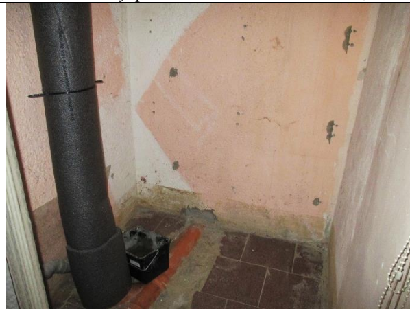
Фото 12. Внутреннее состояние Объекта оценки
