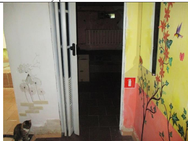
Фото 9. Внутреннее состояние Объекта оценки
