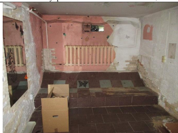
Фото 10. Внутреннее состояние Объекта оценки
