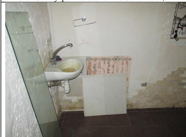
Фото 17. Внутреннее состояние Объекта оценки
