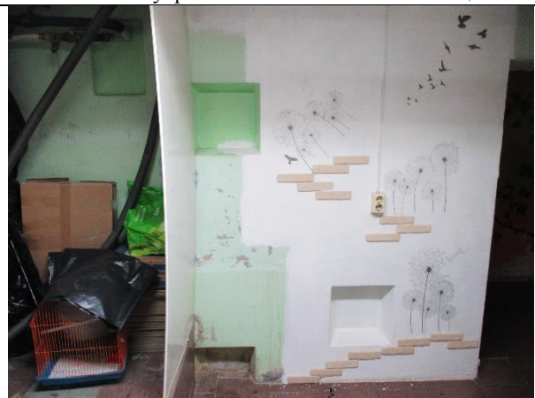
Фото 16. Внутреннее состояние Объекта оценки
