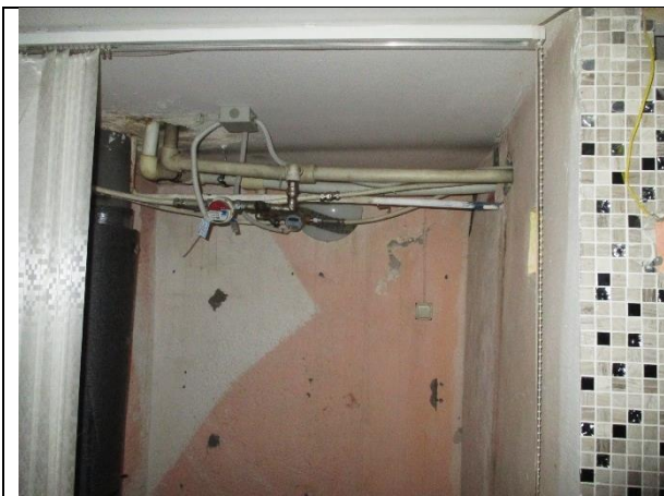
Фото 13. Внутреннее состояние Объекта оценки
