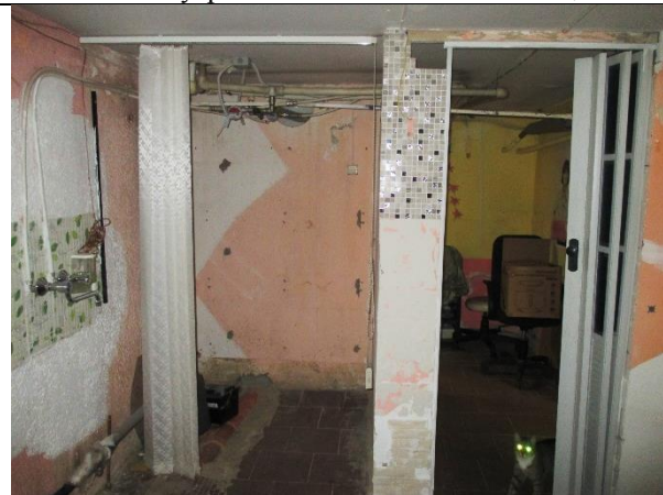
Фото 11. Внутреннее состояние Объекта оценки
